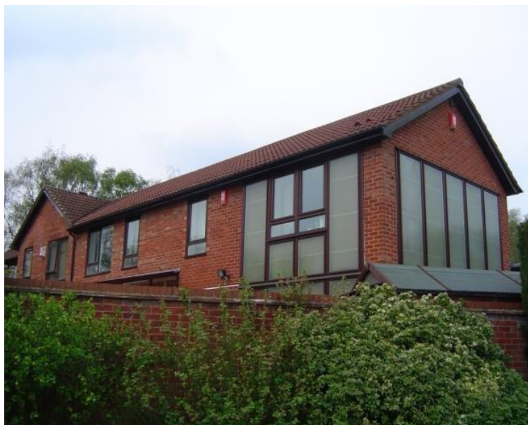
153. ábra Falsíkba illesztett transzparens hőszigetelés
