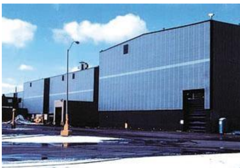
157. ábra Transzparens hőszigetelés raktárépületen
