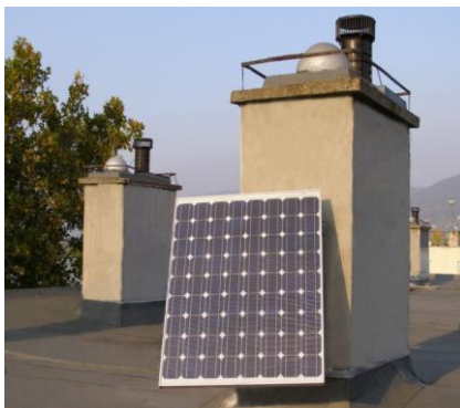
214. ábra Napelemmel hajtott szellőző ventilátor [52]
