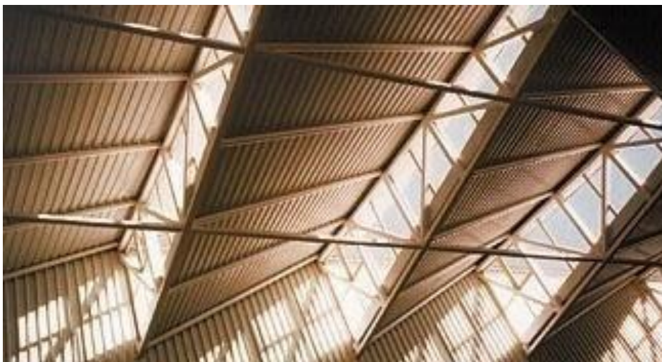
99. ábra Célirányosan tervezett aszimmetrikus felülvilágító [90]
