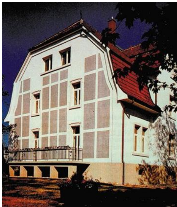
159. ábra Transzparens hőszigetelés transzparens vakolattal barokk épületen
