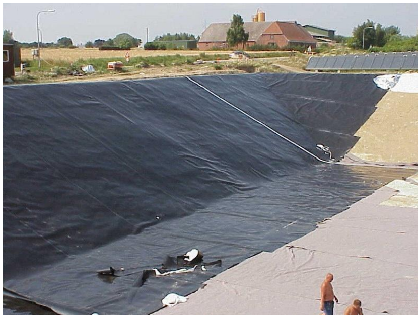
74. ábra A Marstal (DK) hőtároló építése
