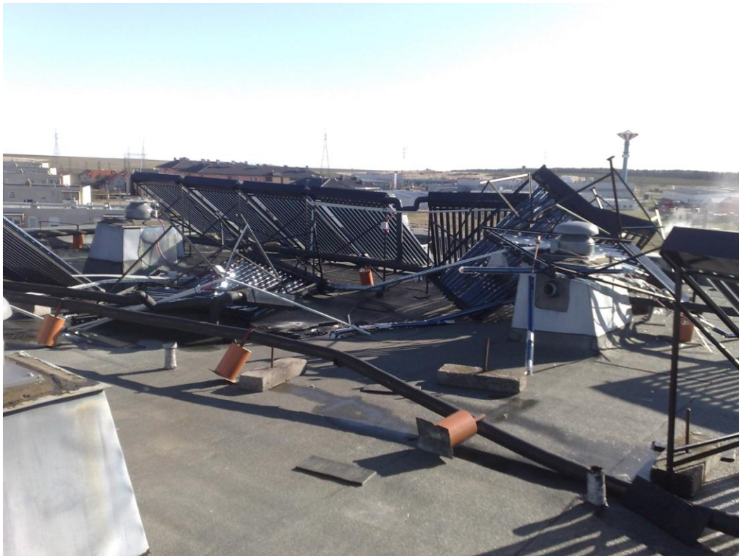
32. ábra Alulméretezett állványzat következménye
