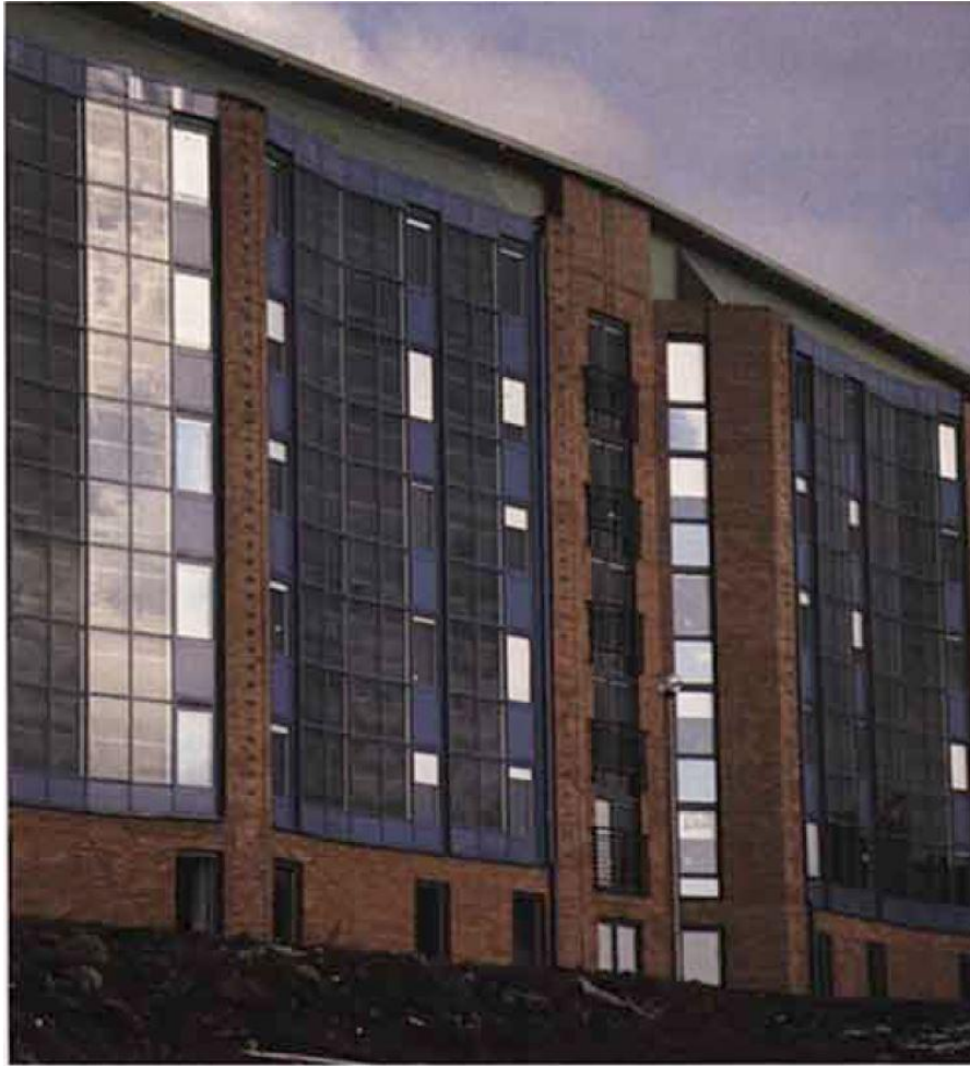
154. ábra Transzparens hőszigetelés a Strathclyde University (Glasgow) kollégiumának homlokzatán
