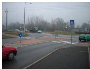
4.6.14. ábra Egysávú körforgalom kialakításának részletei
