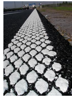
4.2.3. ábra Akusztikus burkolatjel [2]
