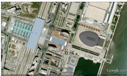
3.5.2. ábra Lisszabon Oriente vasútállomás felülnézete [3]
