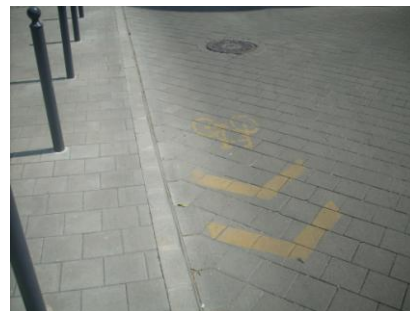
3.1.9. ábra Egyirányú utcában megengedett kétirányú kerékpáros haladás táblázása
