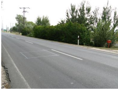
4.2.18. ábra Induktív hurkos forgalmi adatgyűjtő (Fotó: Barabásné Kiss Tímea Magyar Közút Nonprofit Zrt.)
