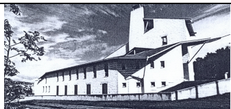
CSÁGOLY: Számadó u. apartmanház
