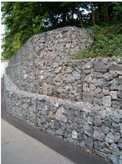
55. ábra Gabionfal jellegzetes keresztmetszeti kialakításai (Papst 1978)
