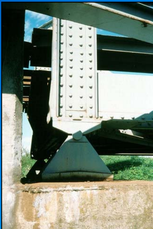
1-2. kép. Fix és göngös acélsaruk
