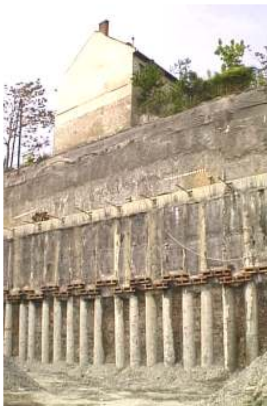
8.13. ábra. Hátrahorgonyozott hézagos cölöpfal részleges lött betontakarással.
