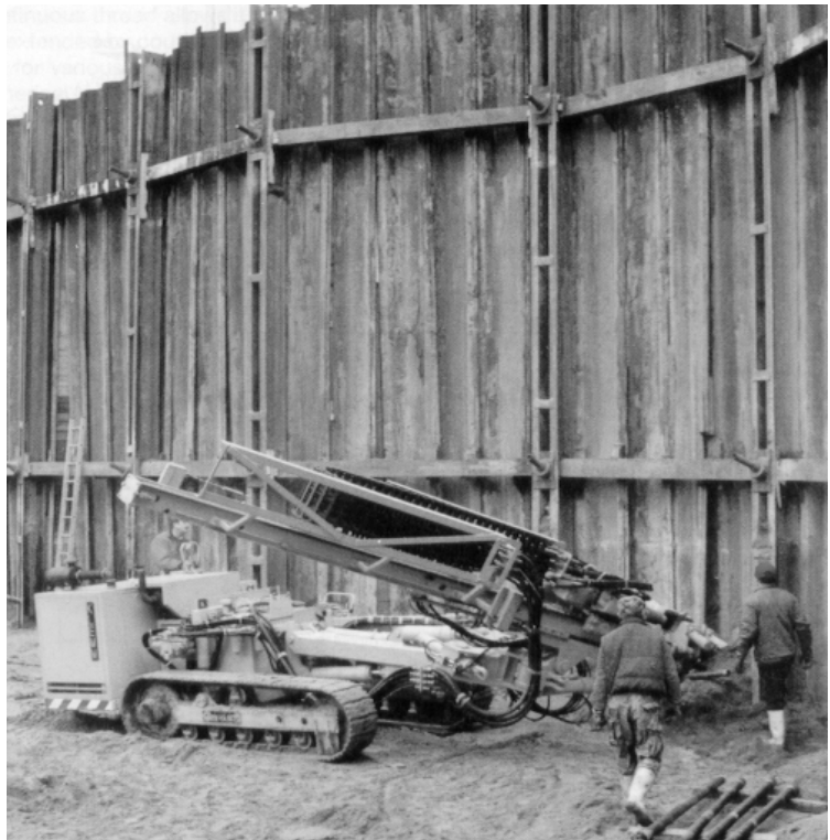
8.26. ábra. Kihorgonyzott berlini dúcolat U-tartókból és acél szádlemezekkel.
