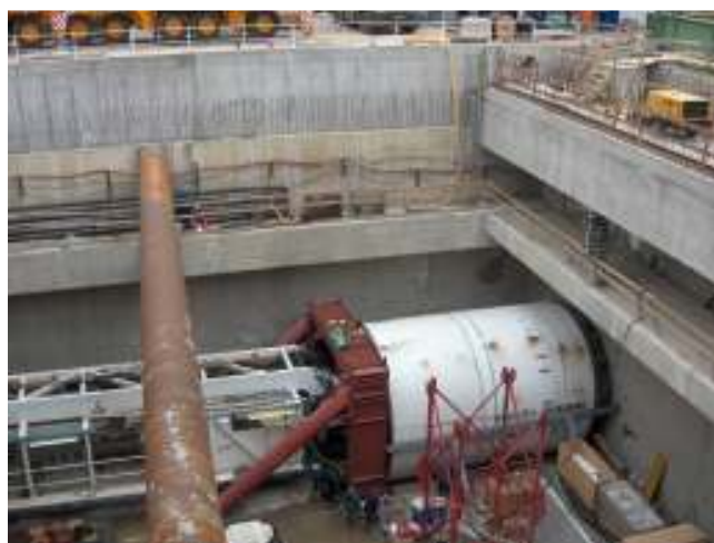
11.26. ábra. Pajzsindítás Kelenföldön.
