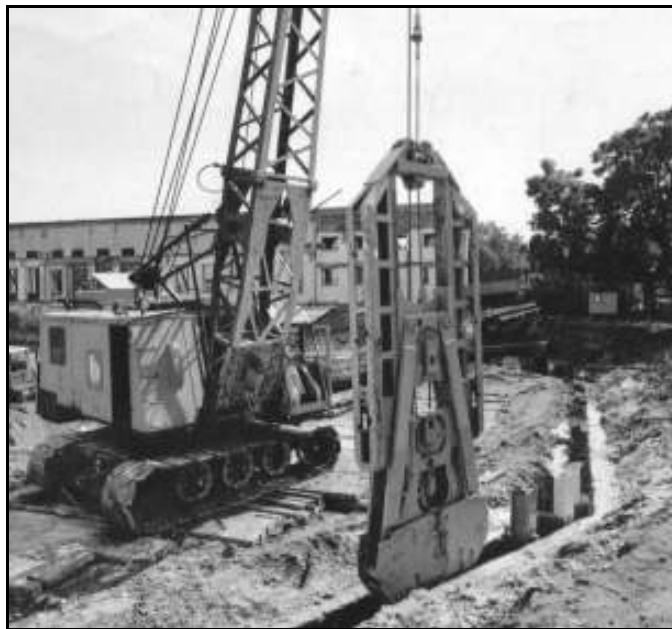
8.10. ábra. Kötélfüggesztésű, réskészítő markológép.
