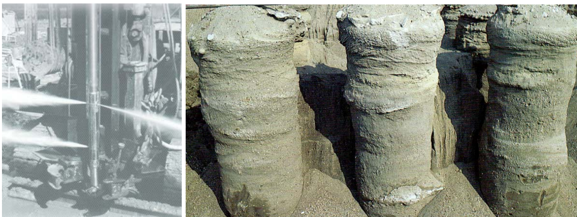
36. ábra A kilövelt levegő és habarcs a fúrószárból. (Soletance-Bachy) A szilárdított jet oszlopok. (Pacchiosi)
