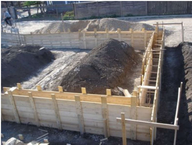
7. ábra Lábazat zsaluzat és zsinórállvány 6
