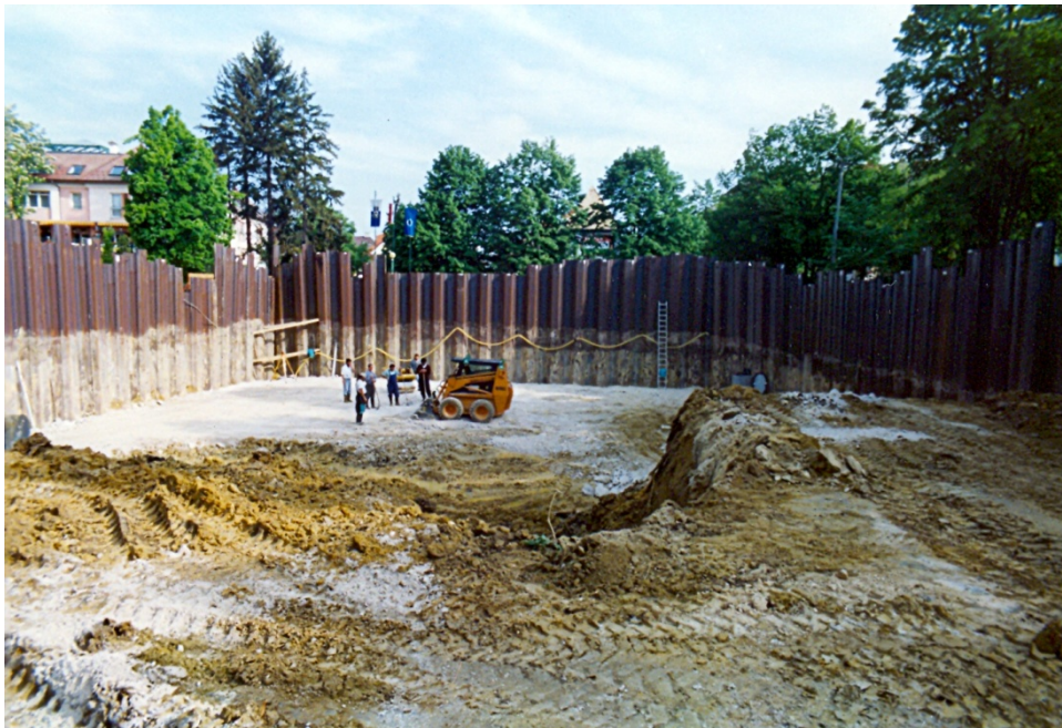
14. ábra Szádlemezek alkalmazása 13
