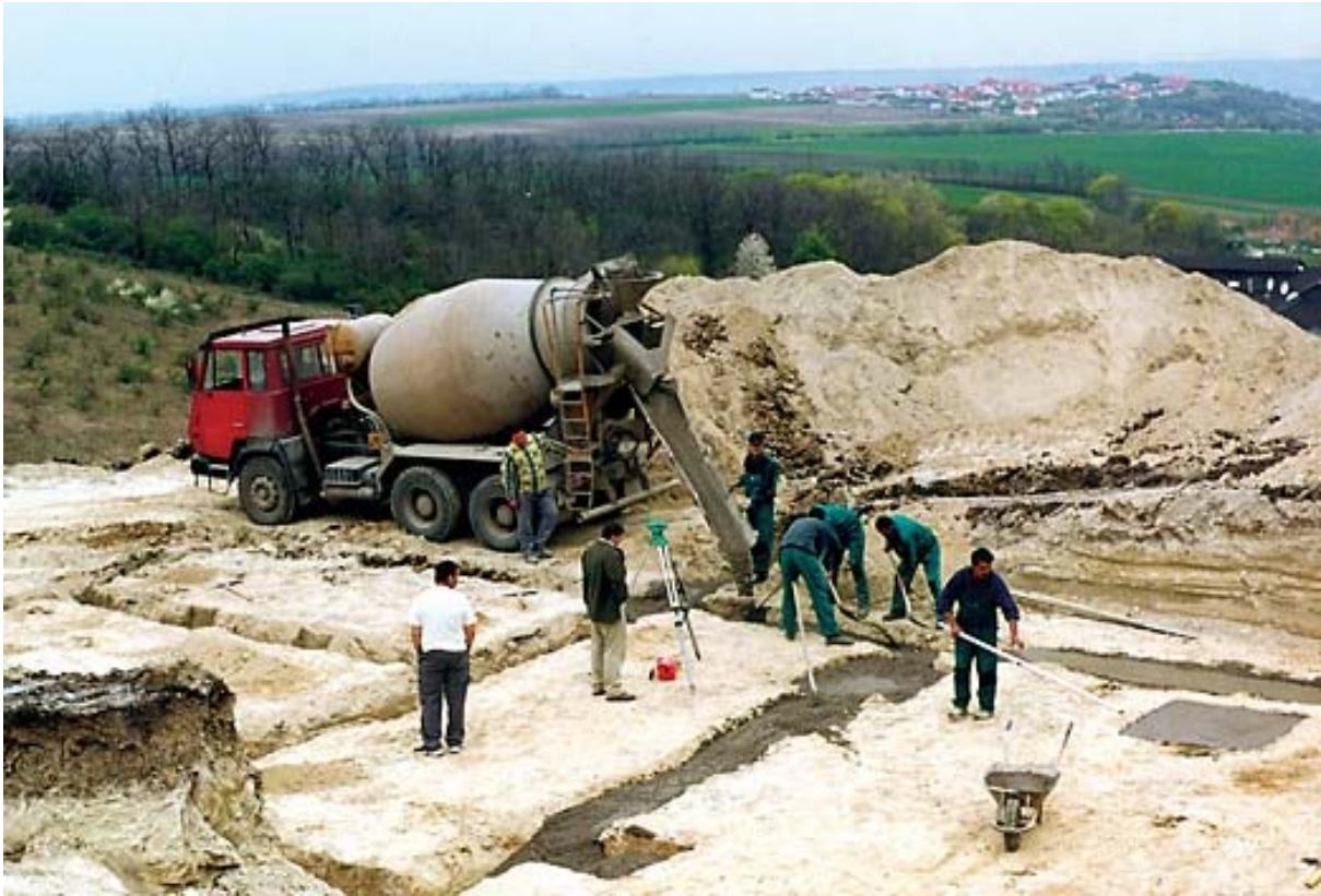
35. ábra Beton bedolgozás Mixerkocsiról 32
