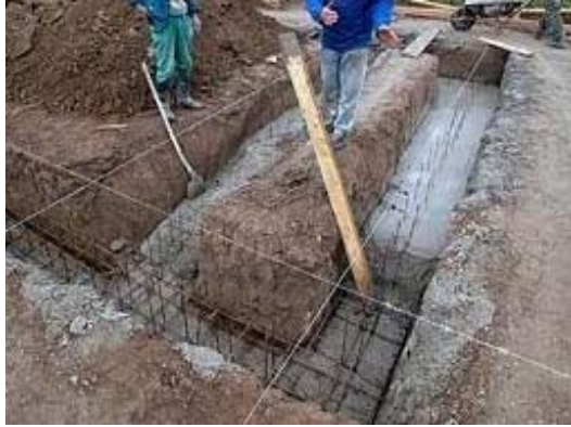
34. ábra Beton bedolgozása 31
