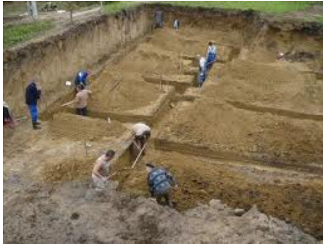
4. ábra Munkaárok kitermelése kézi erővel 4
