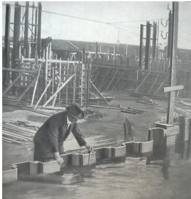
89. ábra: Munkagödör-határolás szádfallal, Sambeek, Holland
