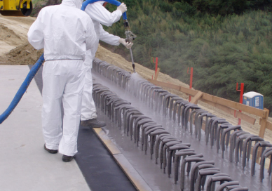
Rugalmas szórt poliuretán szigetelőréteg készítése a hídszegély alá
