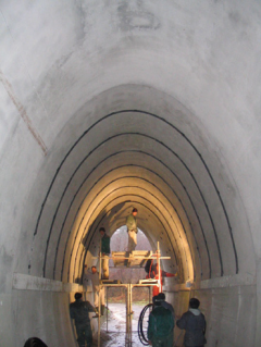
MÁV Rt. Budapest-Szentlőrinc 1831/32 szelvény vasbeton boltozatú vasúti híd szerkezeti megerősítése
