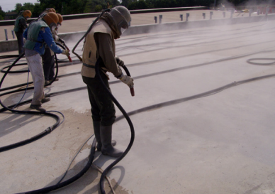
Pályalemez felület előkészítése homokfúvással
