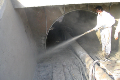
Szárnyfal megerősítése betonlövással
