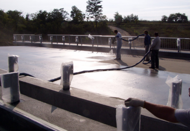
Pályalemez rugalmas szórt poliuretán szigetelőréteg készítése (STO rendszer)
