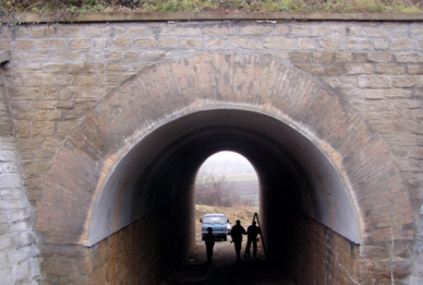
MAV Rt. Pécsbányarendező-Magyarbóly vasútvonal 32/33 szelvény téglaboltozatú vasúti híd szerkezeti megerősítése (injektálás)
