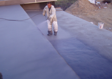
Védőaszfalt alá tapadóhid felhordása (STO rendszer)
