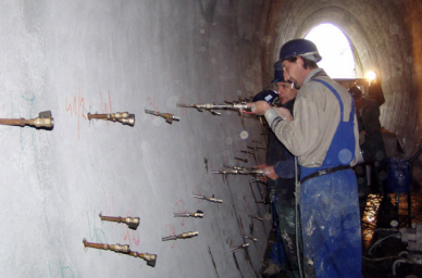
MÁV Rt. Budapest-Szentlőrinc 1831/32 szelvény vasbeton boltozatú vasúti hid szerkezeti megerősítése (injektálás)
