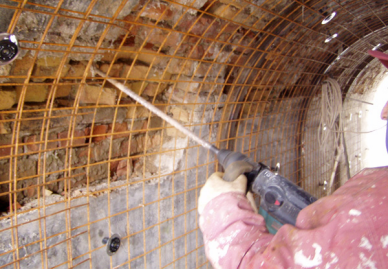
Acélháló felerősítése
