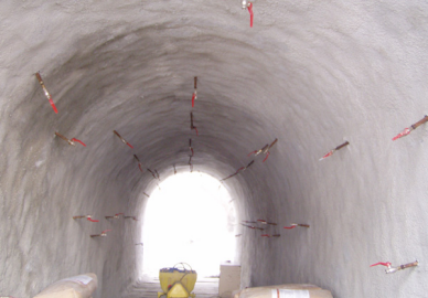
Hídszerkezet injektálása
