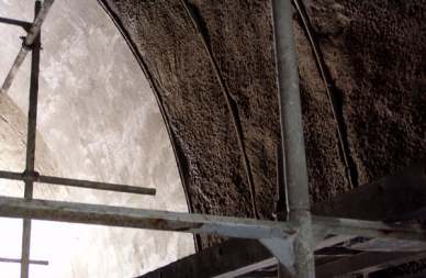
MÁV Rt. Budapest-Szentlőrinc 1831/32 szelvény vasbeton boltozatú vasúti hid szerkezeti megerősítése (betonlövés)
