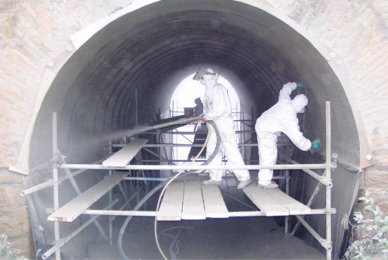
MÁV Rt. Pécsbányarendező-Magyarbóly vasútvonal 32/33 szelvény téglaboltozatú vasúti hid szerkezeti megerősítése
