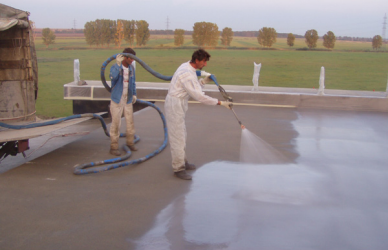
Pályalemez rugalmas szórt poliuretán szigetelőréteg készítése (STO rendszer)
