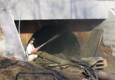
Hídszerkezet megerősítése betonlövéssel
