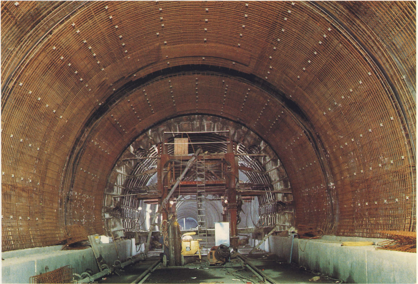
Bewehrung und Schalwagen der Innenschale
