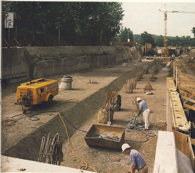
Pfahlgründung Bahnhof Grugastadion
