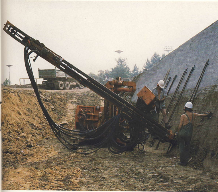
Böschungssicherung mittels Erdnägel und Spritzbetons
