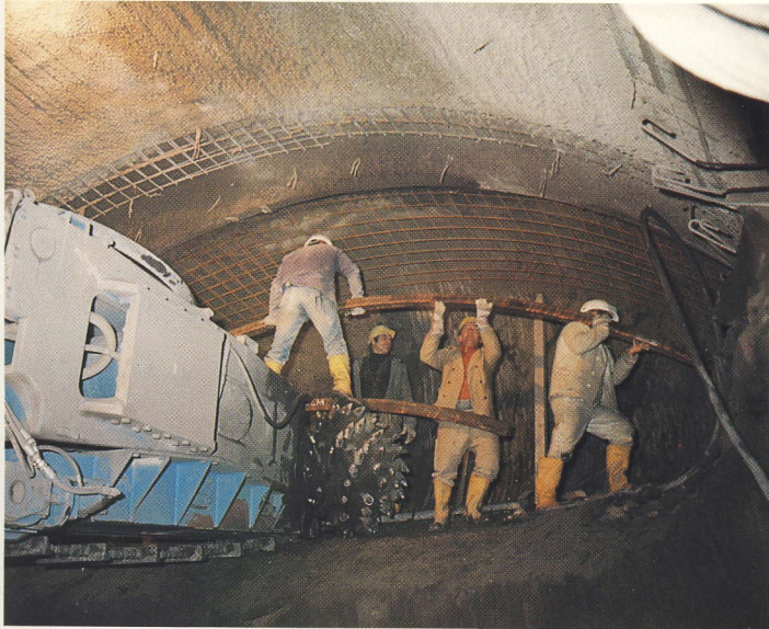
Kalottenvortrieb zweigleisige Röhre
