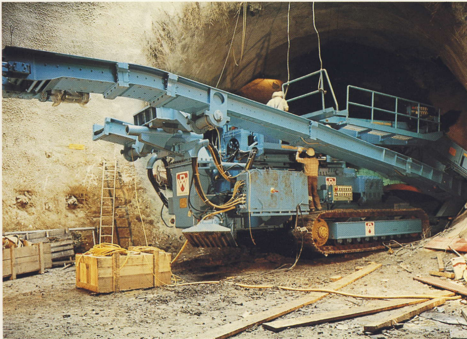
Montage der Teilschnittmaschine WAW 209
