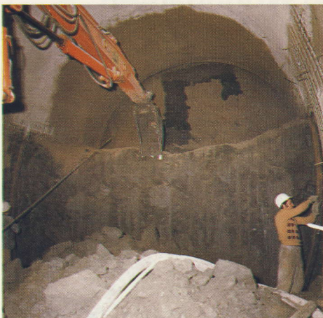
Geschlossene Bauweise, Kalottenausbruch
