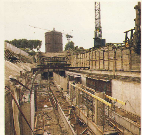
Bauverfahren in offener Bauweise
