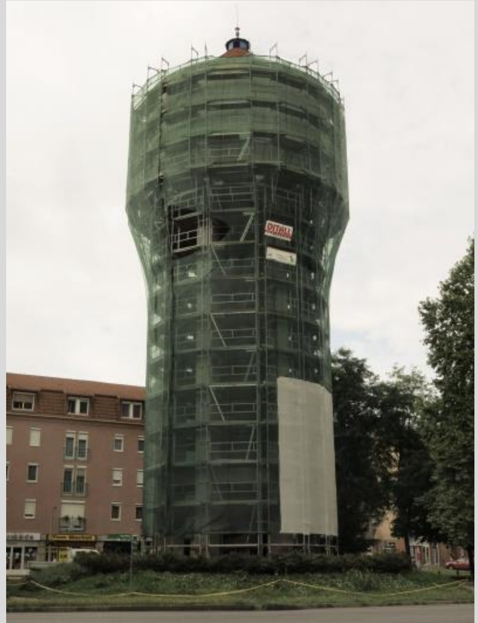
Munkaállvány építése a víztorony körül
