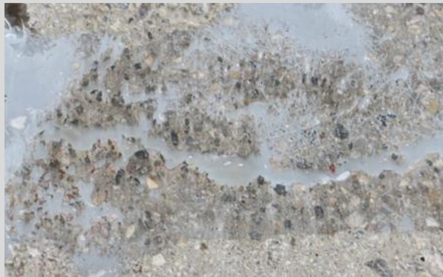
A repedezett betonajzat utólagos javítása
