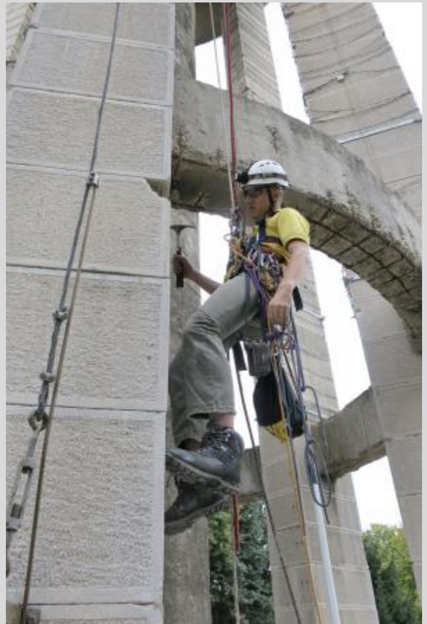
A torony tartópilléreinek állapotvizsgálata alpin technikával
