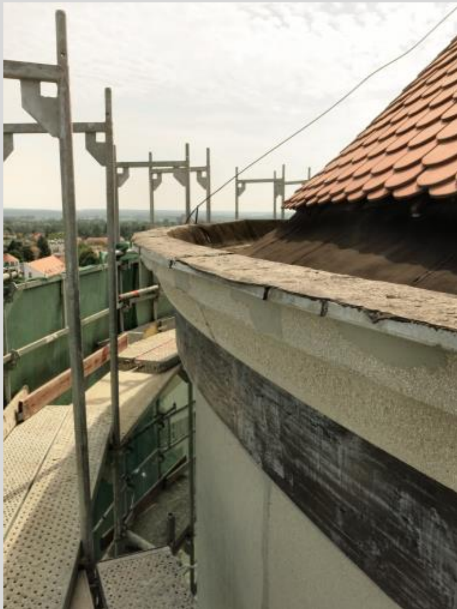
A toronyfej és a tartópillérek javítása
