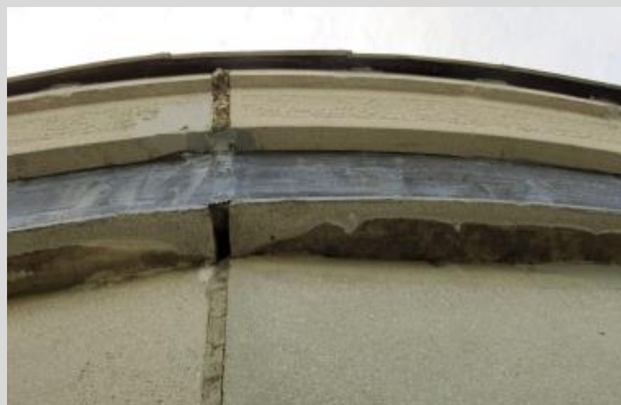
Szénszálas szövet felragasztása
