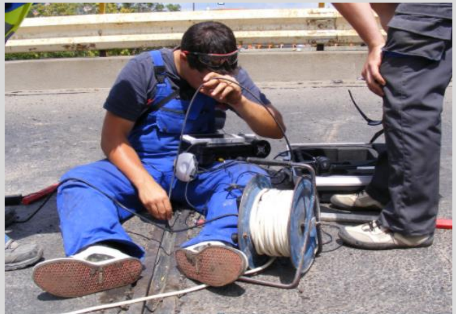
A dilatációs hézagkiképzés feltárása és endoszkópos vizsgálata
