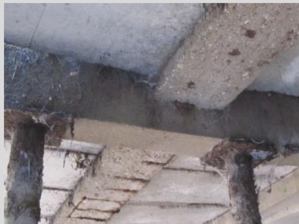
A medence fal-, padozat- és födémszerkezetének károsodásai
