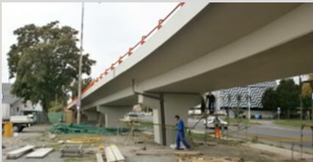
A tartópillérek „lehántolása” és visszabetonozásos megerősítése
