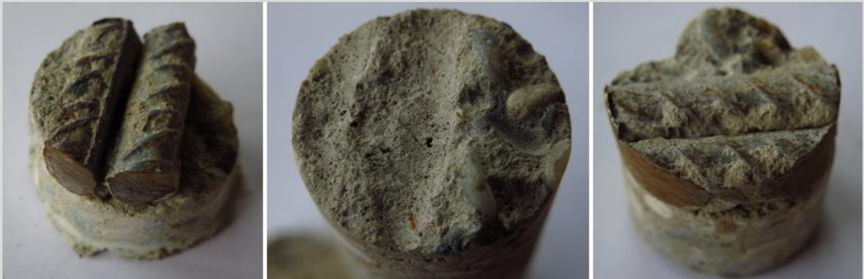
Nem megfelelő tapadás a betonacél és a beton között
