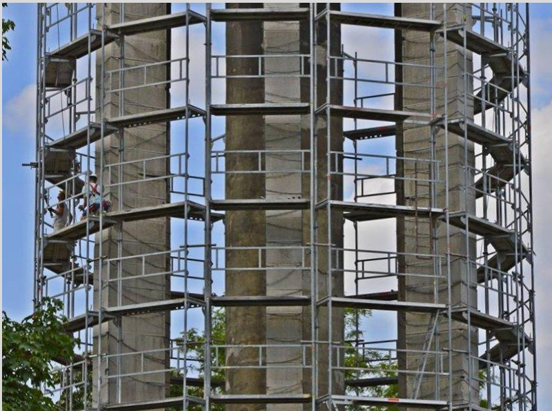
Munkaállvány építése a víztorony körül
