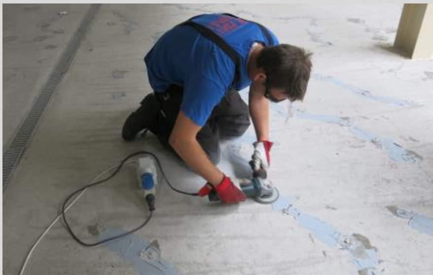
A repedezett betonajzat utólagos javítása
