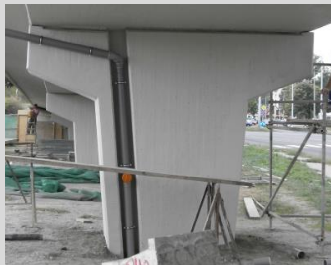
A tartópillérek „lehántolása” és visszabetonozásos megerősítése
