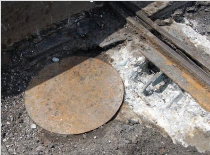
A dilatációs hézagkiképzés feltárása és endoszkópos vizsgálata
