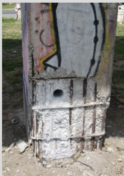
A alaptest feltárása és tartópillérek szilárdságvizsgálata
