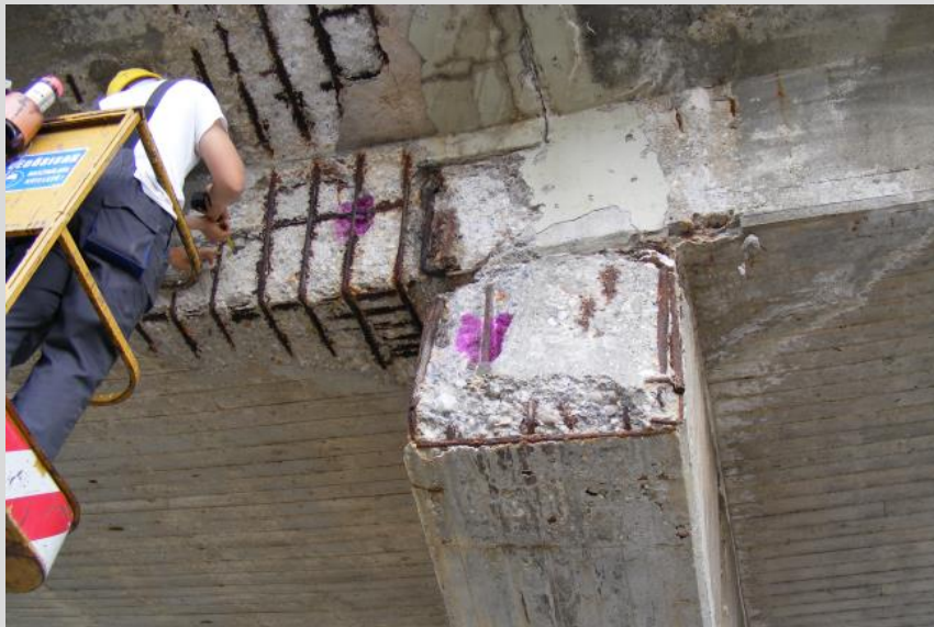
A hídszegély gerendák és a pályalemez diagnosztikai vizsgálatai
