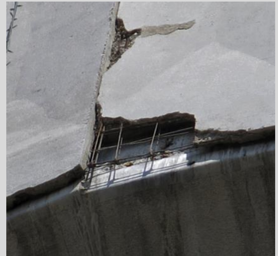
A toronyfej vizsgálata alpiin technikával, és a panelek károsodása
