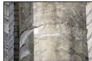
D3. - A lépcsőtér falának állapota
