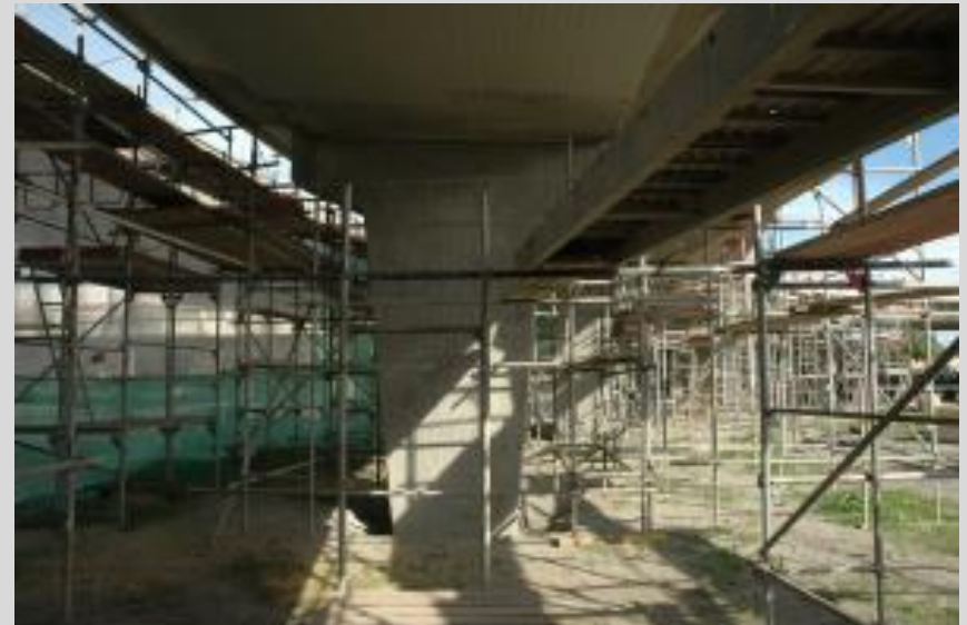
A dilatációs elem elhelyezése és a hídszegély javítása
