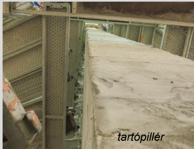
A toronyfej és a tartópillérek javítása
