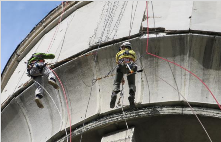
A toronyfej vizsgálata alpiin technikával, és a panelek károsodása
