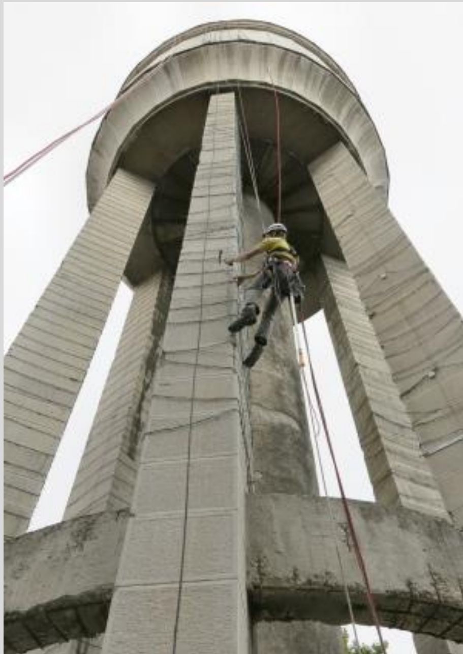
A torony tartópilléreinek állapotvizsgálata alpin technikával
