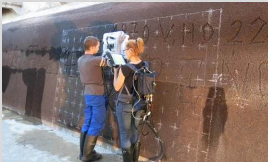
Radarvizsgálatok az alaplemezen és a oldalfalon
