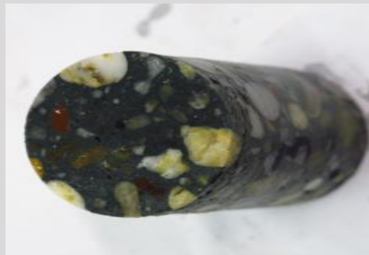
A jó állapotban lévő tömörbeton próbatest
