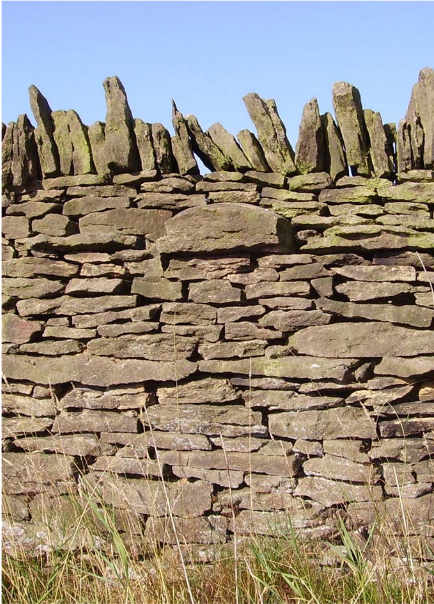
Szárazon rakott kő fal
