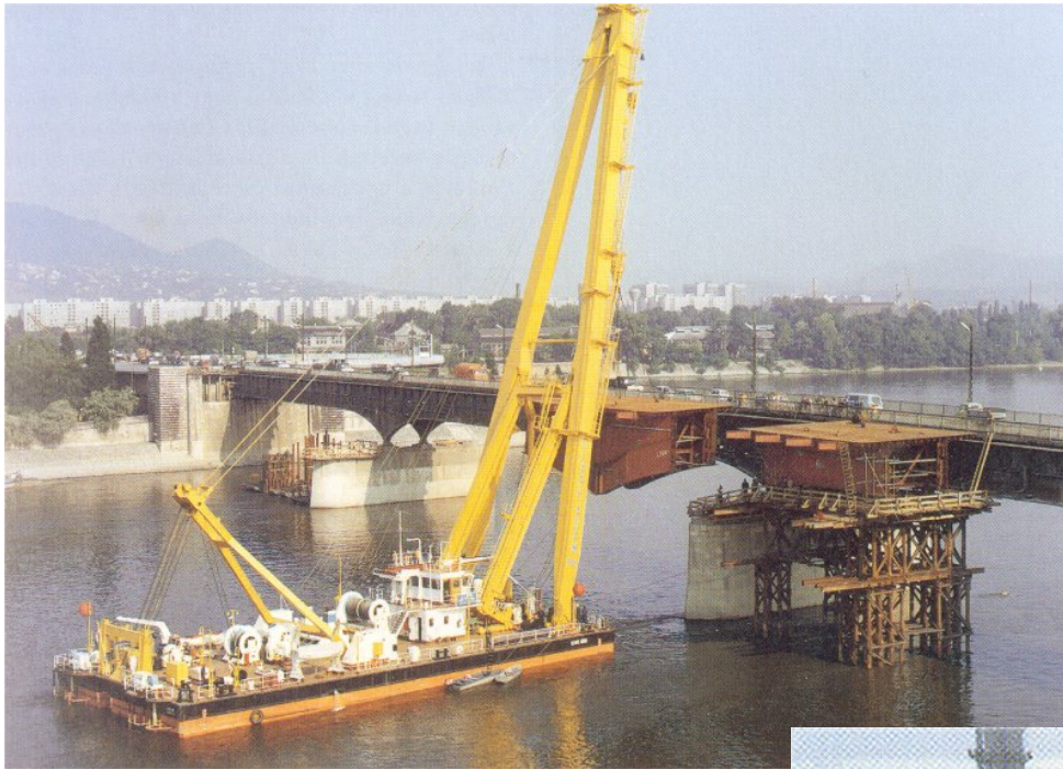
Bp. Árpád híd építése /acélhíd/
