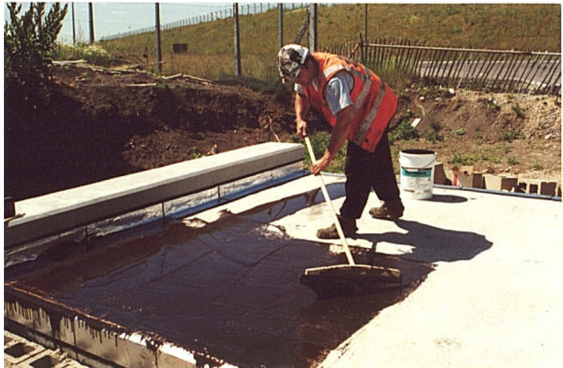
Szigetelő anyag felhordása
