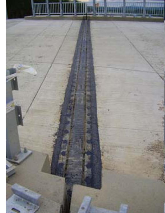
3. A kiöntött pályaburkolat csatlakoztatása
