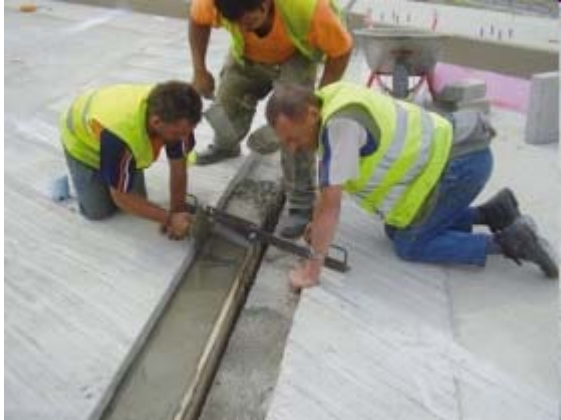
1. A habarcskiegyenlítő réteg készítése
