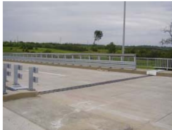
4. Az elkészült dilatációs szerkezet
