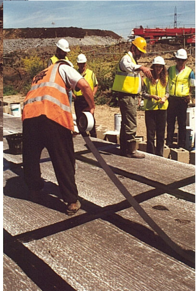
Kellősítő és hézagzáró szalag elhelyezése
