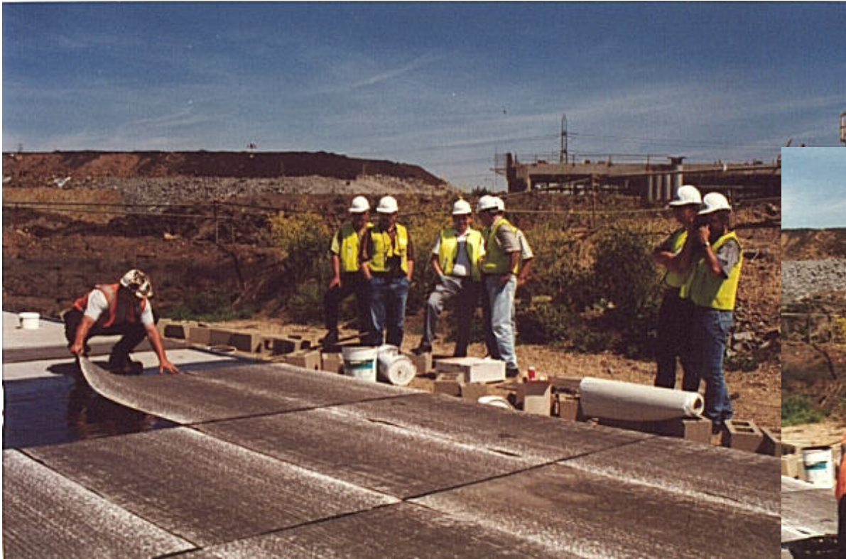
Servipak védőtáblák fektetése
