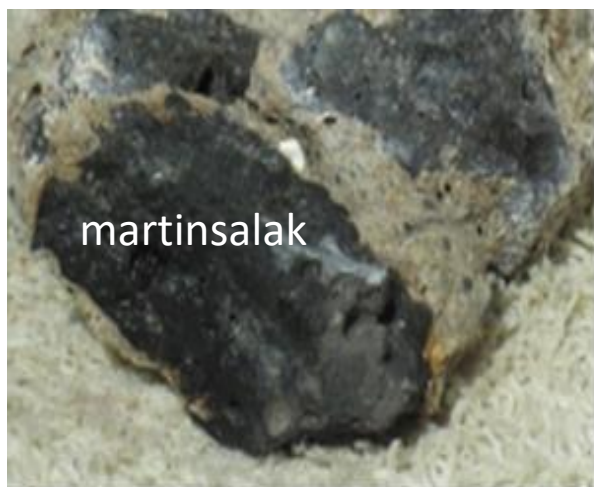
A martinsalak darabok a feltárt falszerkezet betonanyagában
