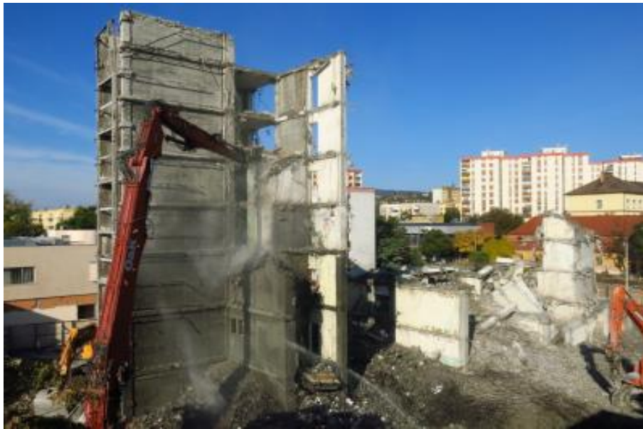
Az épület vázszerkezetének lebontása és a romok eltakarítása
