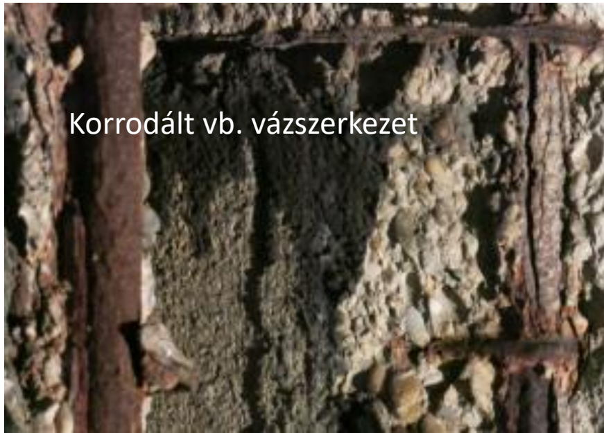
Korrodált vb. födészerkezet
