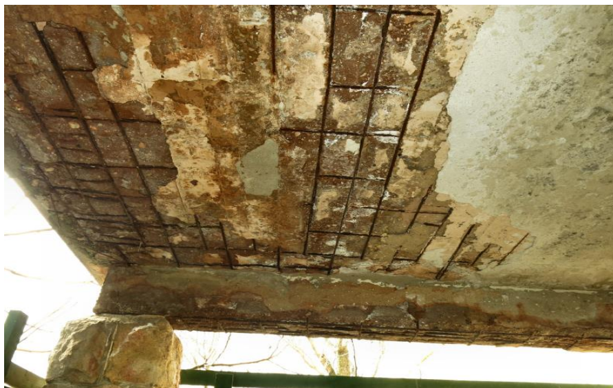
Az épület bauxitbeton terasz- és erkélyszerkezeteinek károsodása
