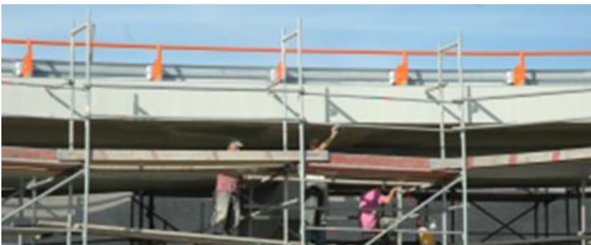
A dilatációs elem elhelyezése és a hídszegély javítása
