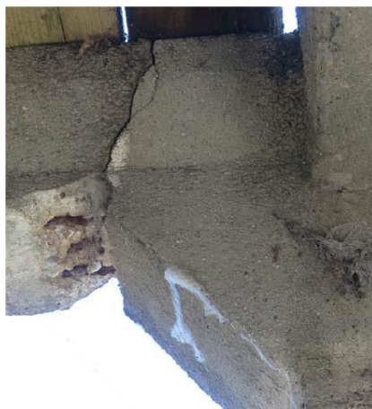
A medence fal-, padozat- és födémszerkezetének károsodásai
