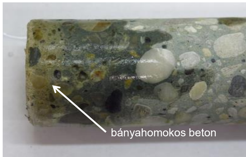
A beton sárga elszíneződése a bányahomok agyagtartalmától
