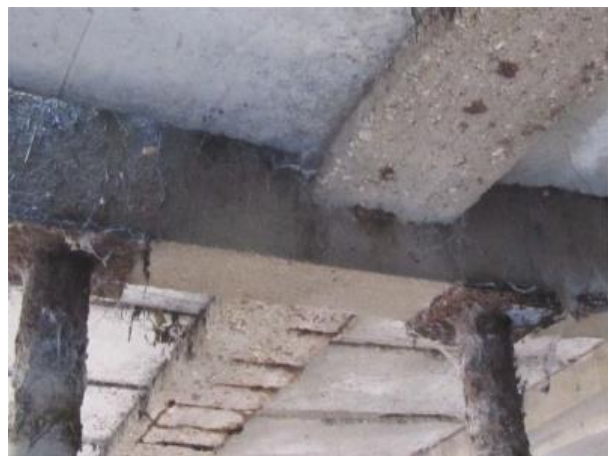
A medence fal-, padozat- és födémszerkezetének károsodásai
