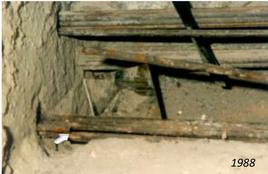
Feszítő huzalok korróziója és szakadása
