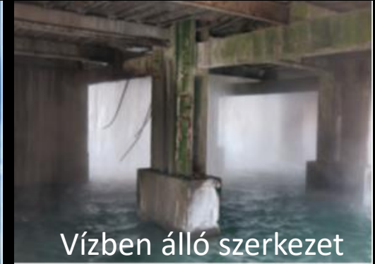
Korrodált vb. vázszerkezet
