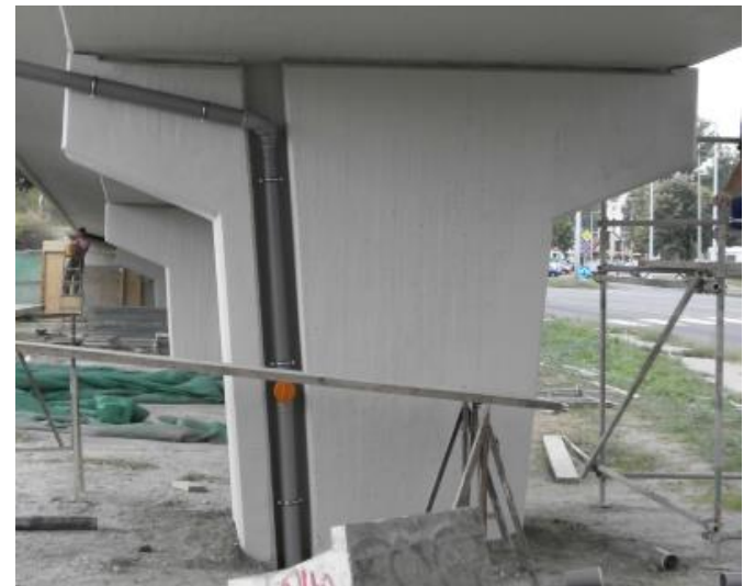
A tartópillérek „lehántolása” és visszabetonozásos megerősítése
