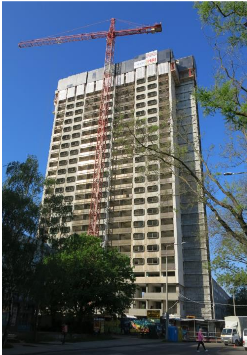
Homlokzati- falpanelek kiemelése az épületből (2016.)
