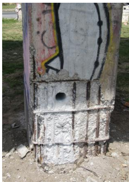
A alaptest feltárása és tartópillérek szilárdságvizsgálata
