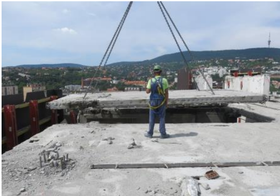
A födémpanelek kibontása a vázszerkezetből
