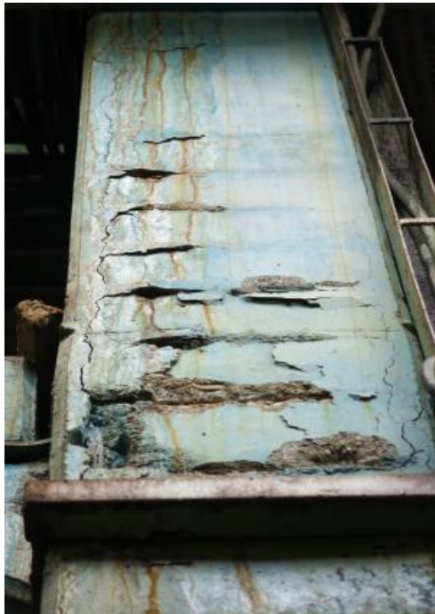
Szerkezet károsodás a kengyelek környezetében
