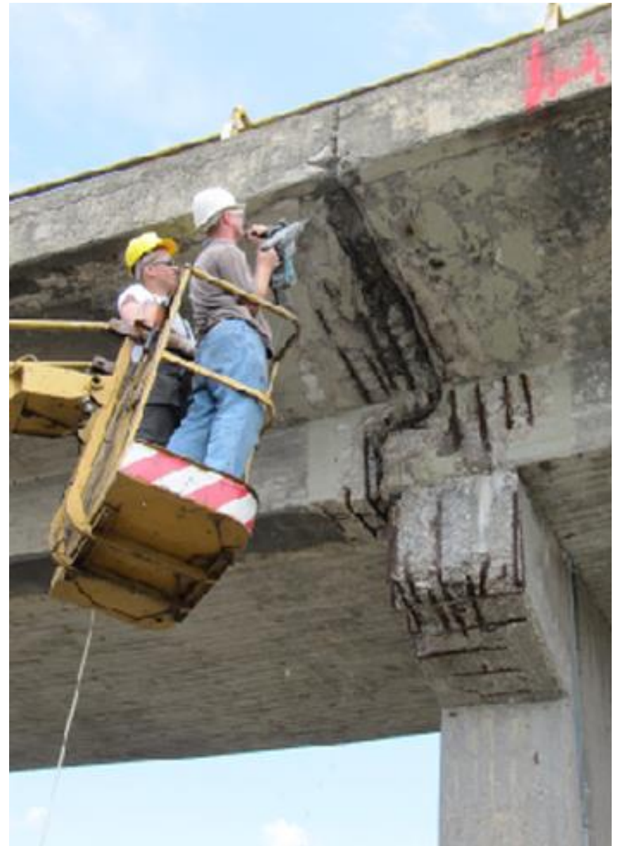
A hídszegély gerendák és a pályalemez diagnosztikai vizsgálatai
