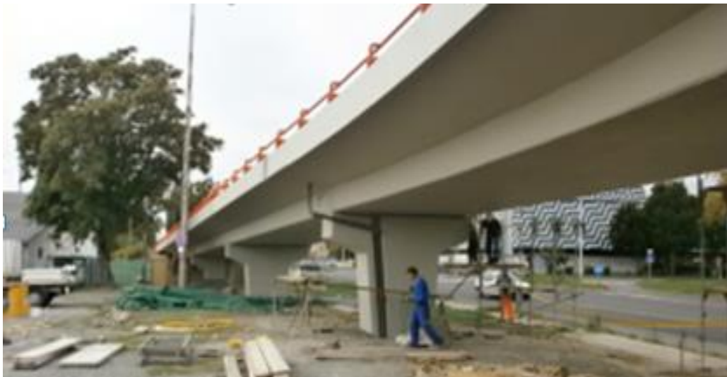
A tartópillérek „lehántolása” és visszabetonozásos megerősítése
