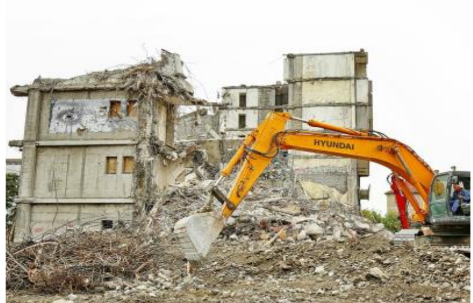
Az épület vázszerkezetének lebontása és a romok eltakarítása
