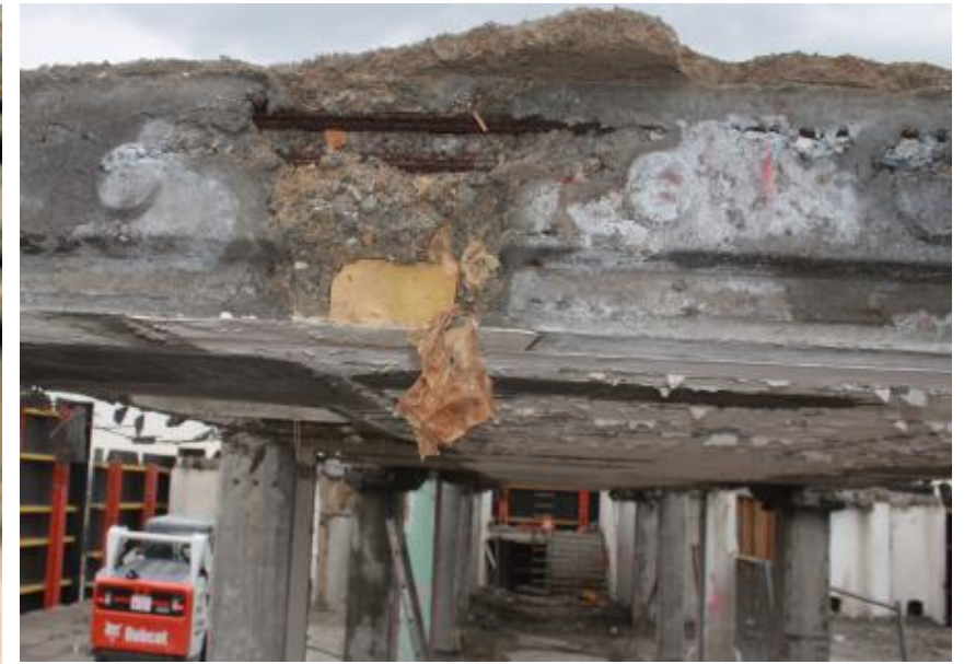
Feszítő huzalok korróziója és szakadása
