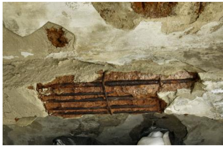
Az épület bauxitbeton terasz- és erkélyszerkezeteinek károsodása
