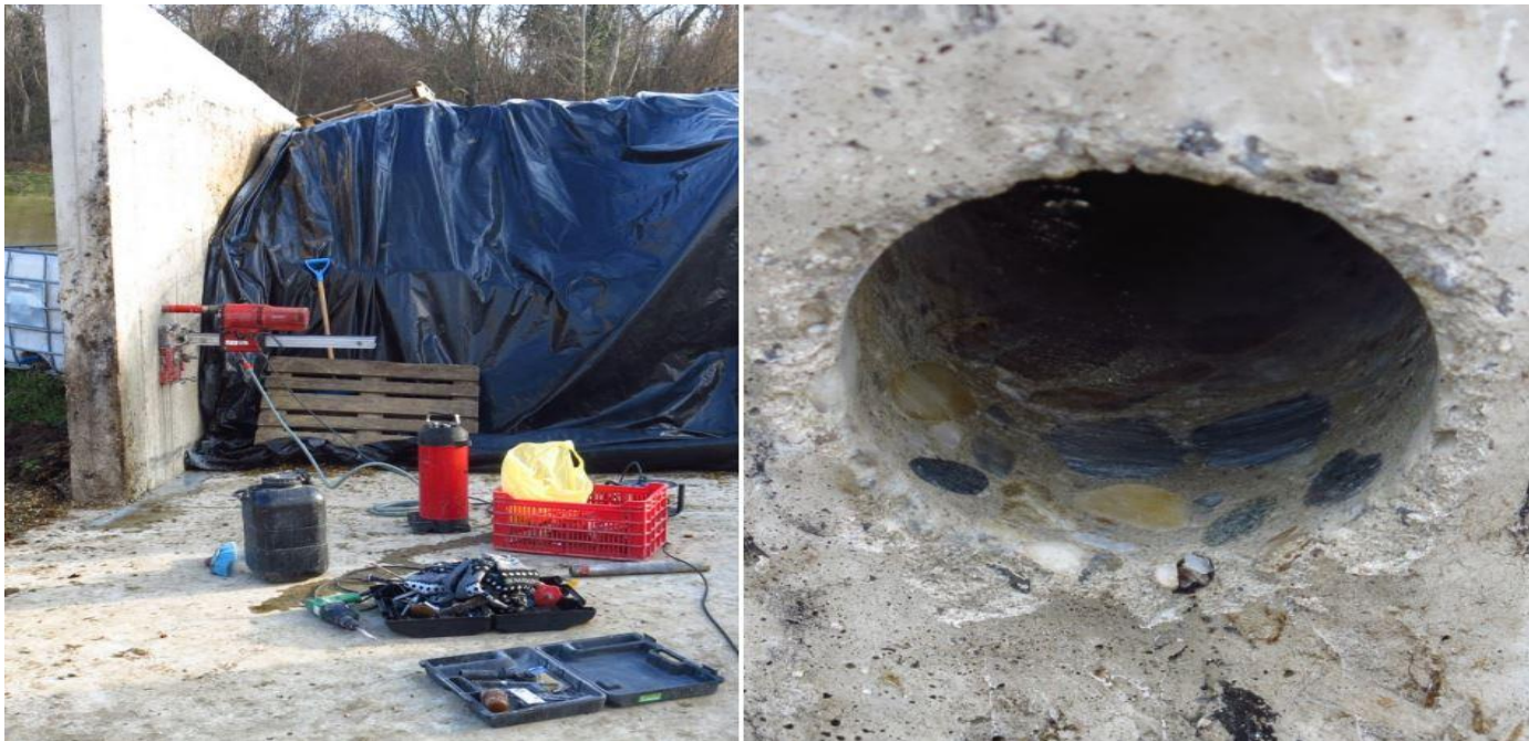
Furatminta vétel a vasbeton siló támfalszerkezetéből
