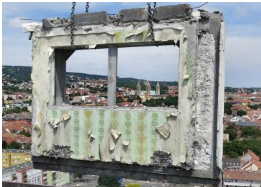
Homlokzati- falpanelek kiemelése az épületből (2016.)
