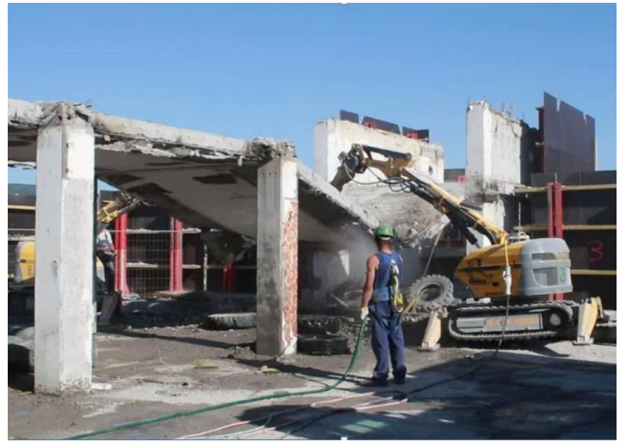
A födémpanelek kibontása a vázszerkezetből
