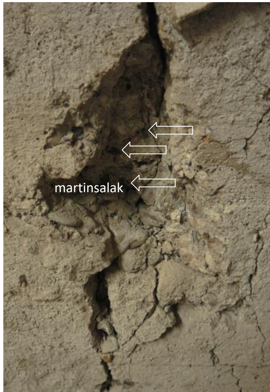
Martinsalak darabok a károsodott falszerkezetben
