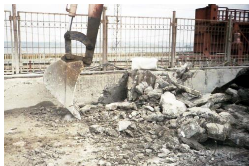
A pályalemez betontörmelékének elszállítása
