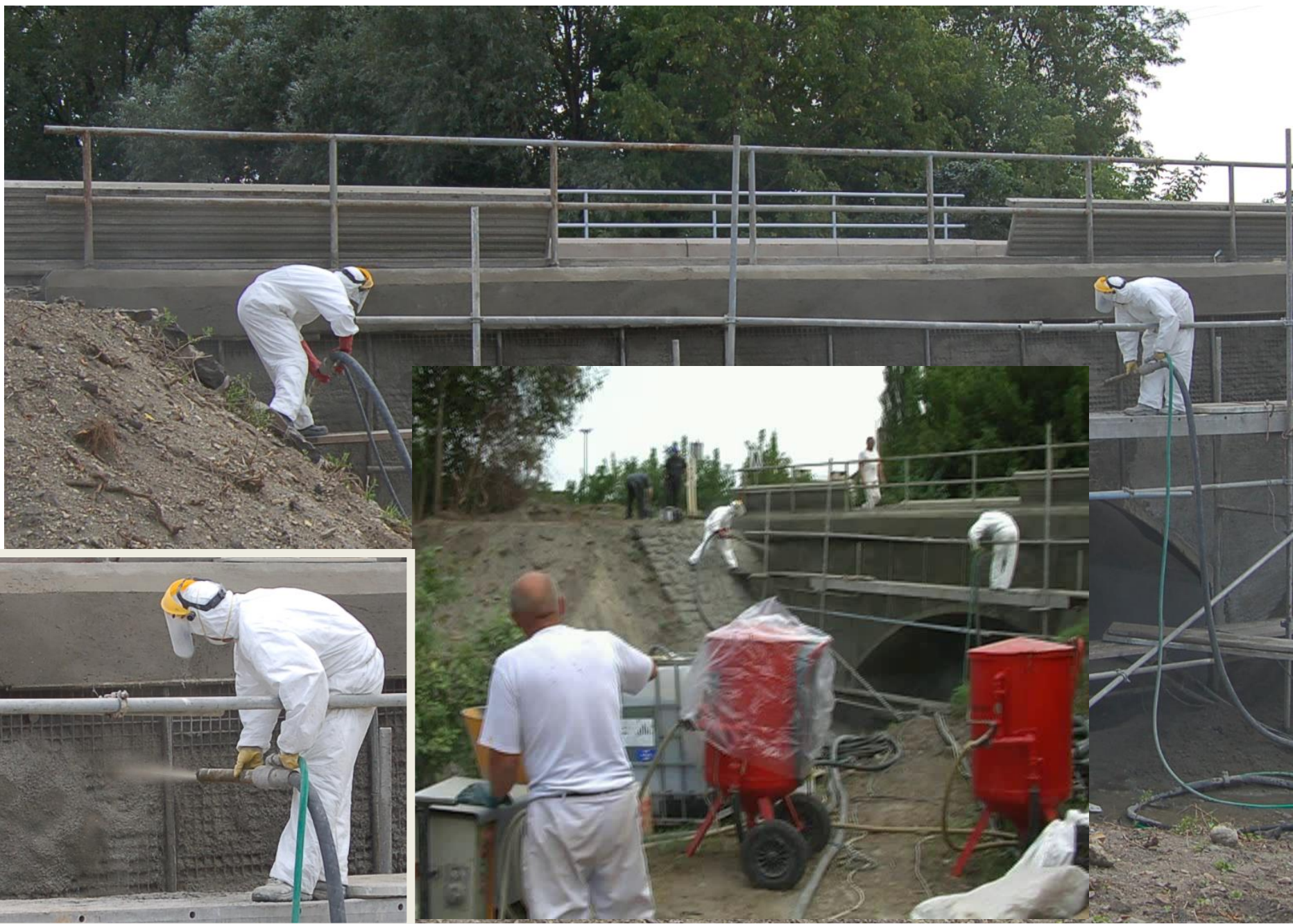
Vasúti- és közúti hidak megerősítése, lőtt betonnal
