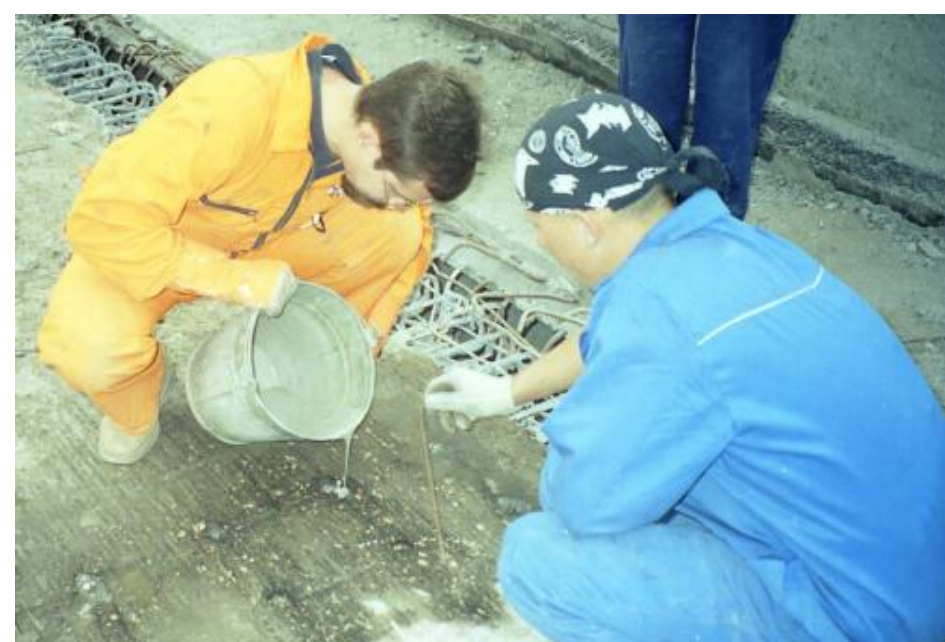
A fűrt lyukak kiöntése duzzadó habarccsal
