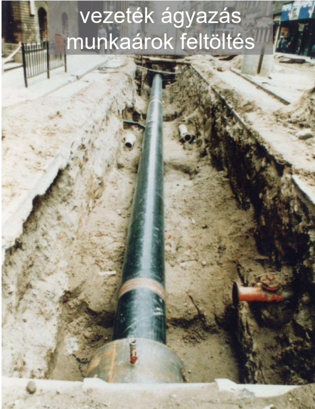
csőben-cső kiinjektálás
