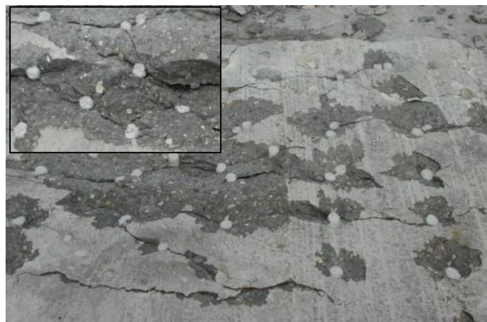
Habarcs duzzadásának roncsoló hatása
