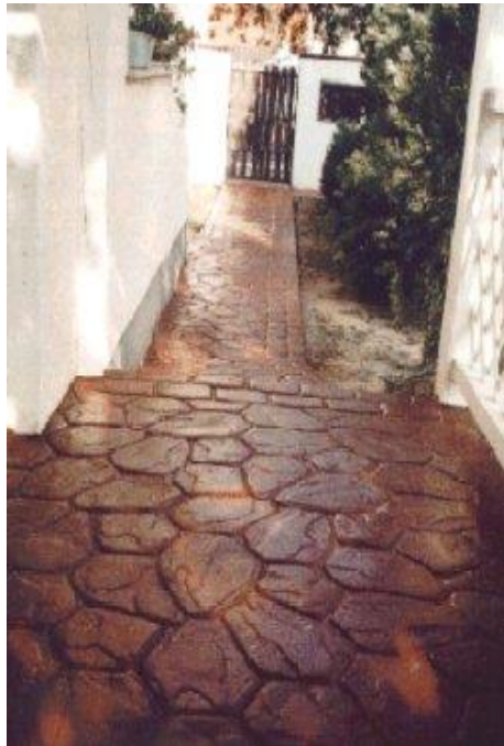
Lenyomatos mintázatú útburkolat készítése
