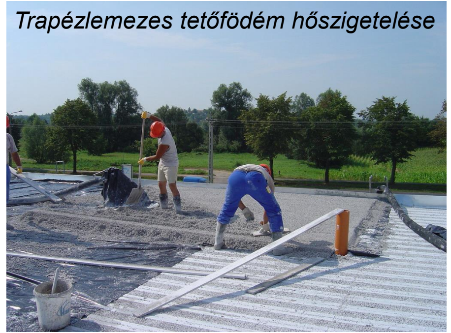
Polisztirol beton előállítása
