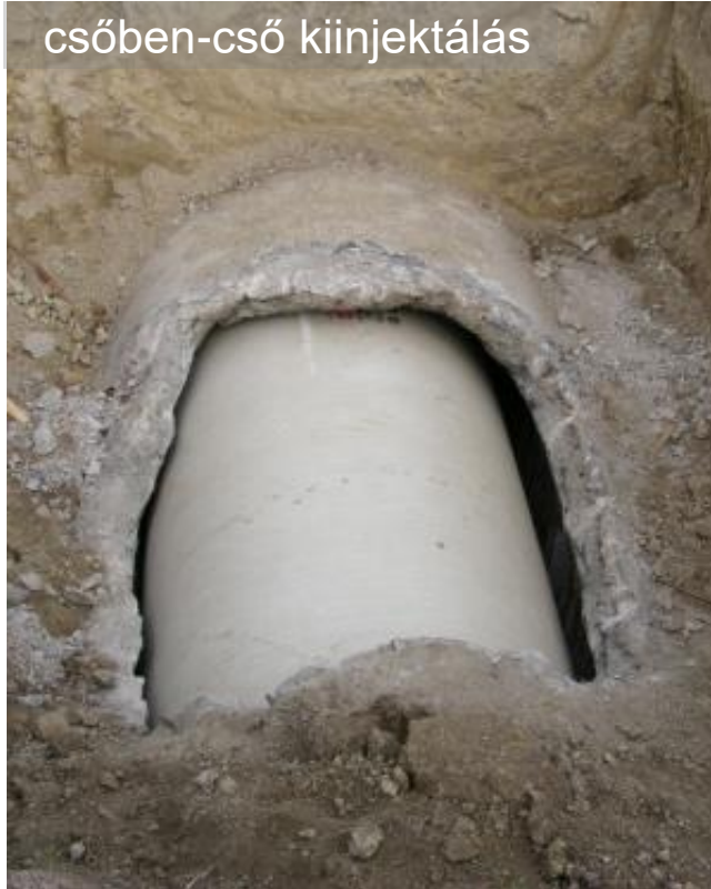
épületszerkezeti üregfeltöltés
