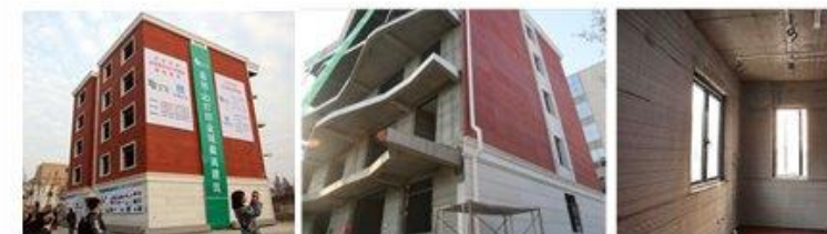
2015 Lakóépület Suzhou, Kína (falak nyomtatva, födém hagyományos vb. szerkezet)
