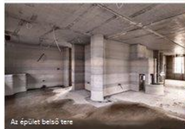
Betonépület extruderes 3D nyomtatása és építése (Németország)
