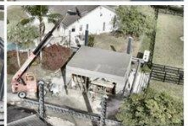
3D technológiával nyomtatott farm földmészkezetének betonozása (Florida)
