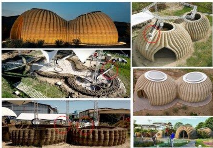
Agyag (vályog) épület „Delta” rendszerű 3D nyomtatása, Olaszország
