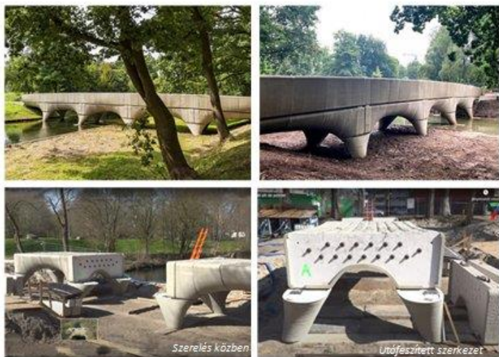
Leghosszabb 3D nyomtatású kerékpáros híd 29 m Nijmegen Hollandia 2021
