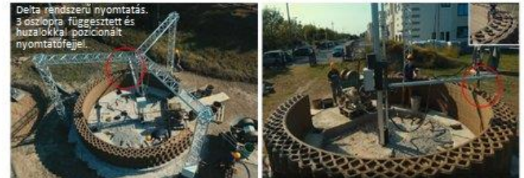
„Öko”-fenntartható épület Anyagok: agyag, iszap, homok; mész riszhej, rizs szalma Fal és födém hőszigetelő-burkolata (bio-vakolata) riszhejből. Falszerkezet üregei riszhejjel feltöltve.
