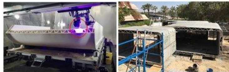
Térelém épületek nyomtatása és helyszíni szerelése
