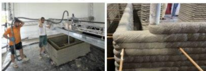
A nyomtatott építmény falazatának kialakítása
