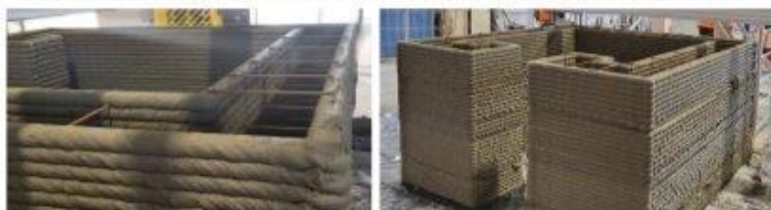
Falszerkezet összekapcsolása betonacélakkal
