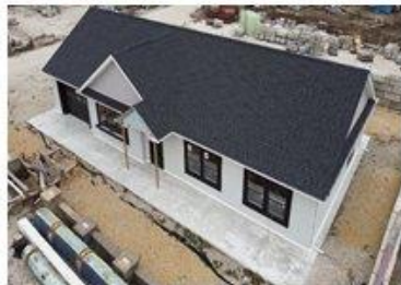
Mobil és fix keretes portárendszerű technológiával nyomtatott épületek
