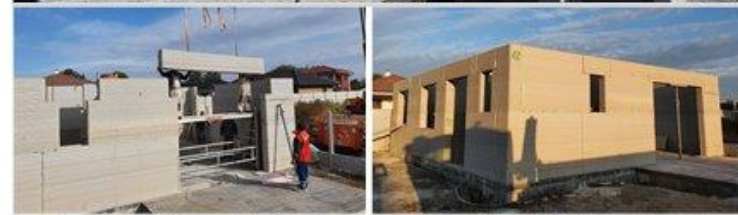
Portálrendszerű technológiával előre nyomtatott panelelemből építve (Szlovákia)
