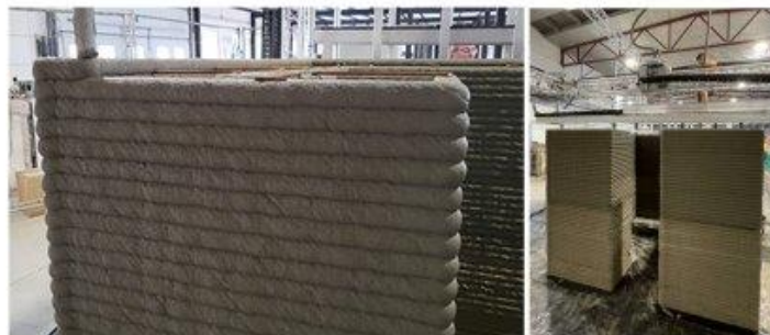
A falszerkezet nyomtatása
