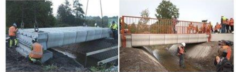
A híd elemeinek összeszerelése és feszítése
