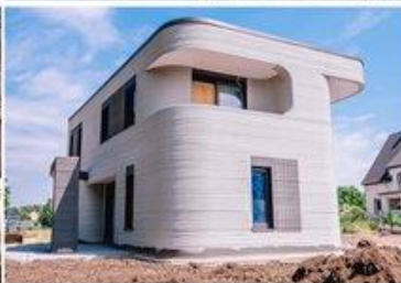
Betonépület extruderes 3D nyomtatása és építése (Németország)
