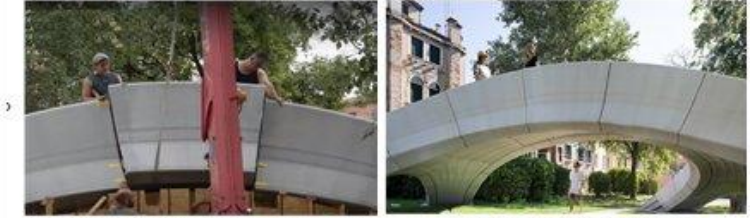
Hagyományos boltíves hídkonstrukció kialakítása
