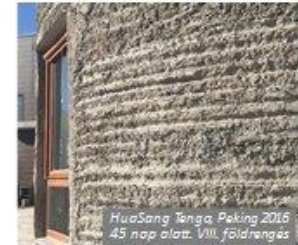
Nem elemekből összeszerelt 3D nyomtatott épület
