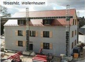
Mobil és fix keretes portárendszerű technológiával nyomtatott épületek
