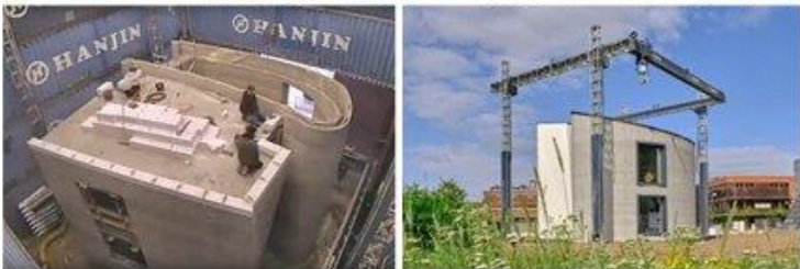
Az első 3D technológiával nyomtatott 2 szintes lakóépület (Belgium)
