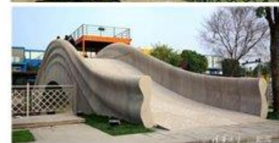
Gyalogos betonhid Shanghai (2019) Hossza: 26 m szélesség: 3,6 m Robot karos nyomtatással előregyártva. Helyszínen szerelve üreges elemekből.
