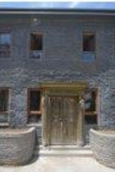
Nem elemekből összeszerelt 3D nyomtatott épület
