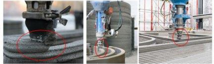
3D betonnyomtatás extruder-es technológiával (különböző nyomtatófejekkel)
