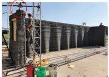
Amerikai katonai bázis (Champaing) Portárendszerű technológiával nyomtatták. 45m 2 40 óra alatt épült
