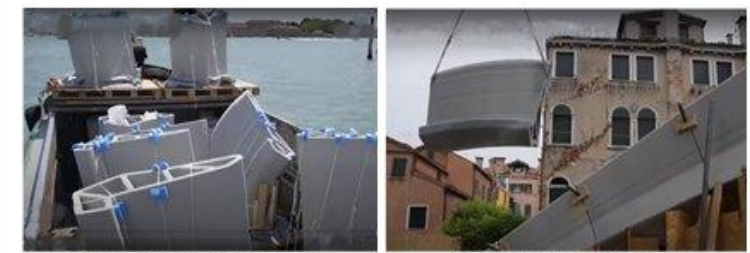
A híd elemeinek helyszínre szállítása
