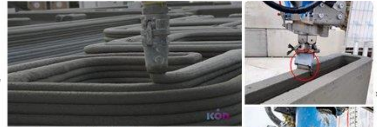
A nyomtatófejet elhagyó friss betonrétegek
