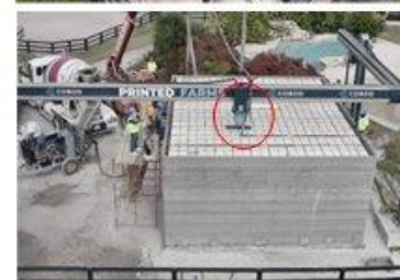
3D technológiával nyomtatott farm földmészkezetének betonozása (Florida)
