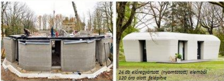
3D technológiával előregyártott elemekből összeszerelt lakóház, Hollandia
