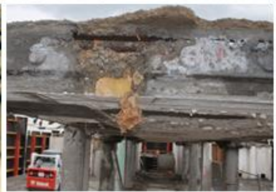
Feszítő huzalok korróziója és szakadása
