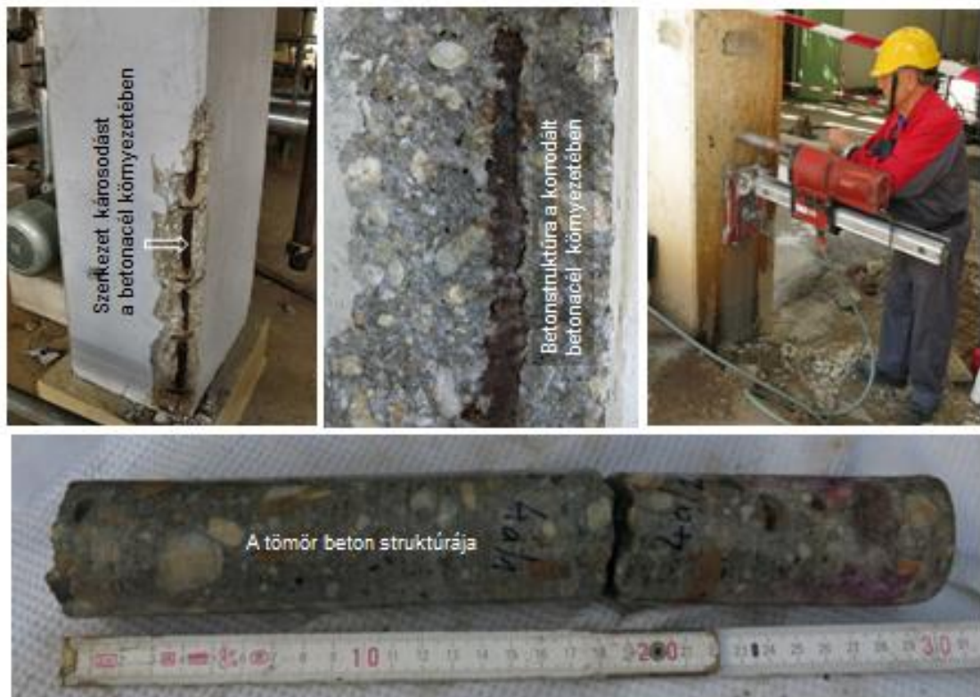
A vasbeton szerkezet betonanyagának vizsgálata.
