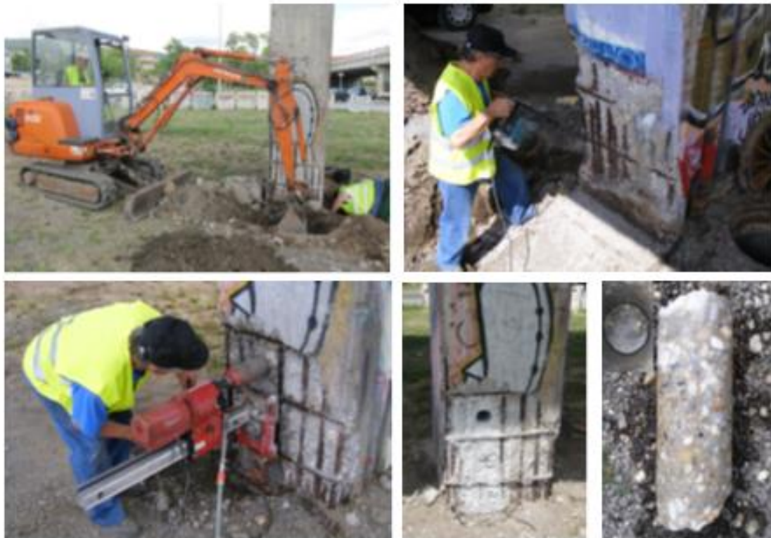
A alaptest feltárása és tartópillérek szilárdságvizsgálata
