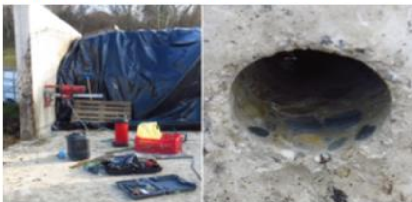
Furatminta vétel a vasbeton siló támfalszerkezetéből
