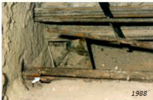
Feszítő huzalok korróziója és szakadása
