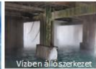
Korrodált vb. vázszerkezet
