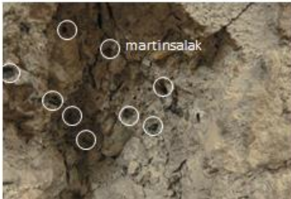
Martinsalak darabok a károsodott falszerkezetben
