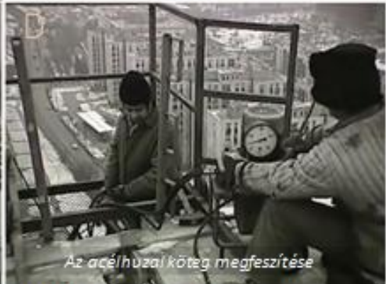
A pillér-födém kapcsolat kialakítása, összefeszítéssel
