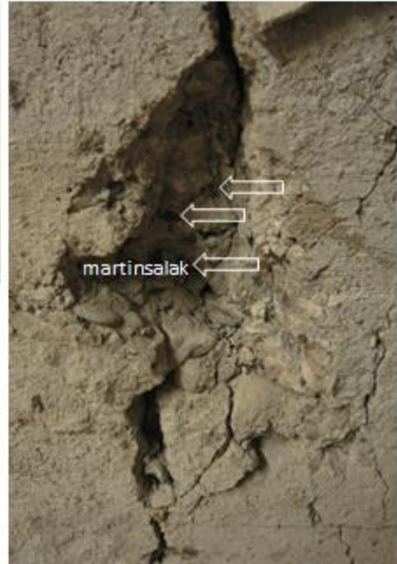
Martinsalak darabok a károsodott falszerkezetben
