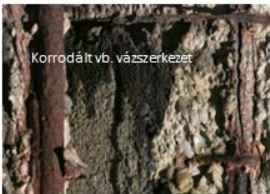
Korrodált vb. födémszerkezet
