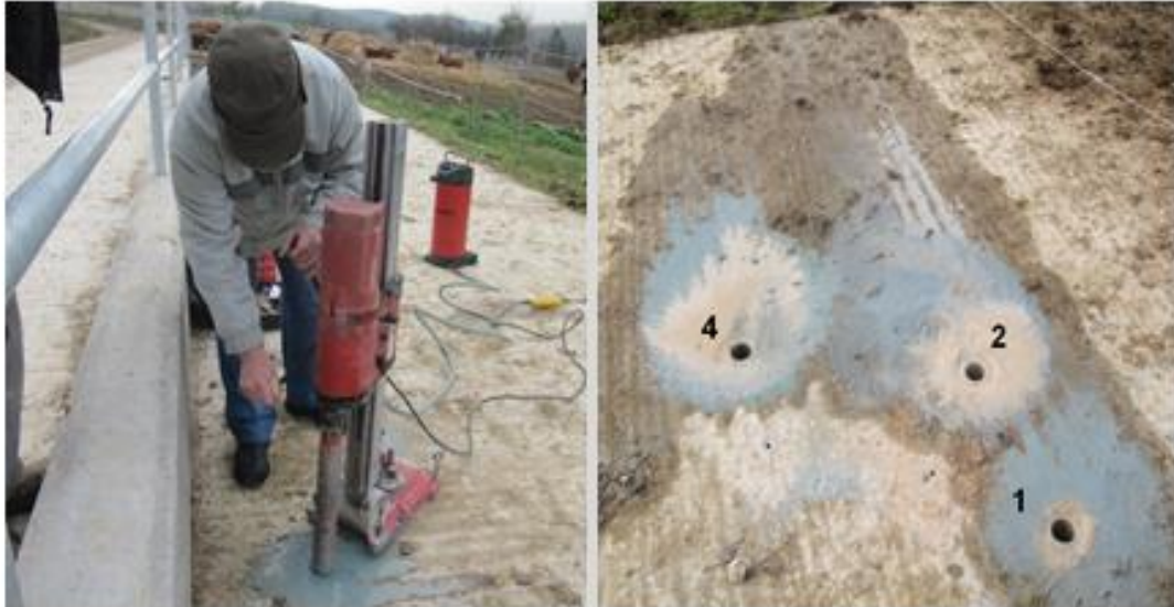
Henger minták kifúrása a betonlemezről
