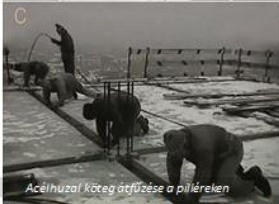
A pillér-födém kapcsolat kialakítása, összefeszítéssel
