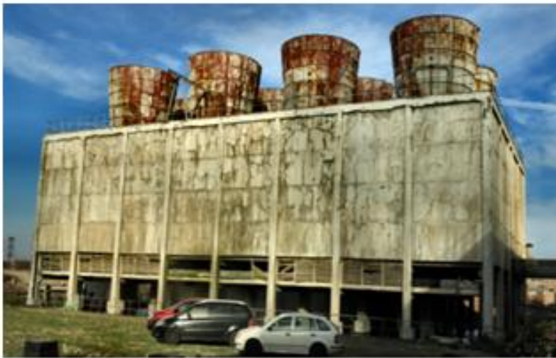
Ajkai Hőerőmű hűtőtorony épülete (2018)
