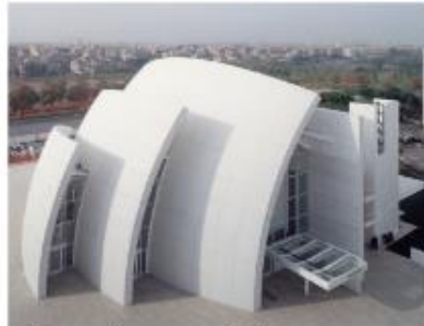
Öntisztuló betonfelület és épülethomlokzat Richard Meier jubileumi templom Rómában
