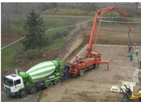
Betonszivattyú alkalmazása
