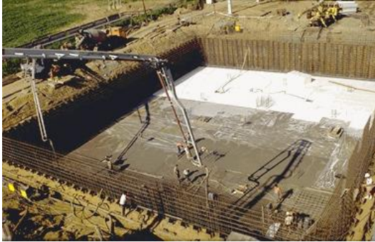
Tömegbetonozási technológia
