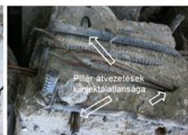
IMS utófeszített vasbeton vázszerkezeti rendszer
