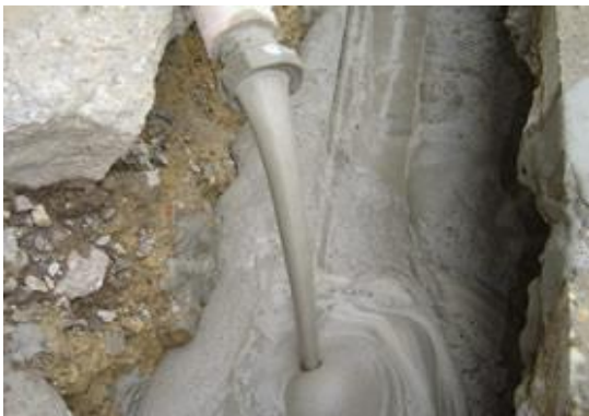
Közművezeték ágyazása habcementtel
