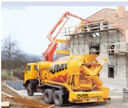
Mixer gépkocsi betonszivattyúval
