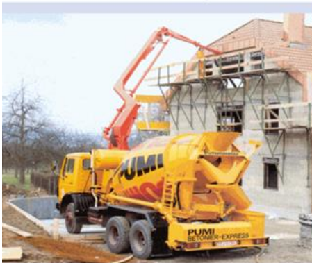
Mixer gépkocsi betonszivattyúval
