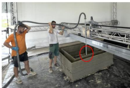
A nyomtatott építmény falzatának kialakítása
