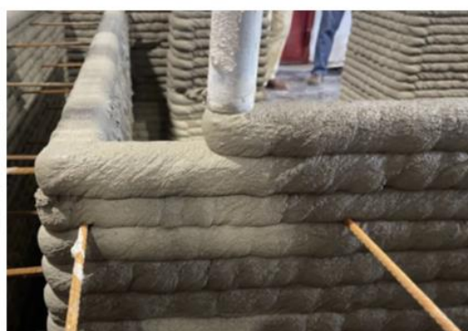
Az építmény falszerkezetének nyomtatása
