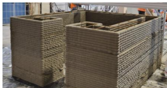
A kinyomtatott falszerkezet (betonépítmény)
