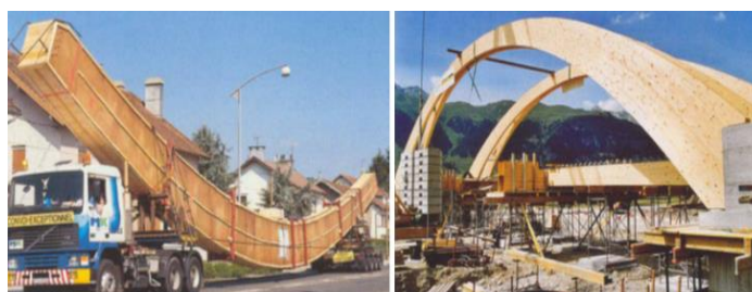
A szerkezeti elemek szállítása és szerelése
