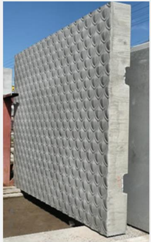
Matricás zsaluzattal készült látványbeton felületek
