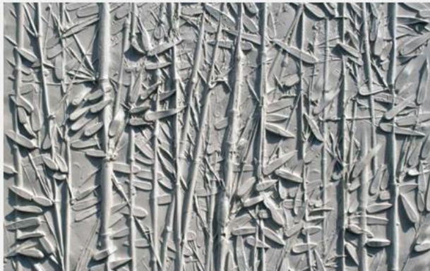
Matricás zsaluzattal készült látványbeton felületek
