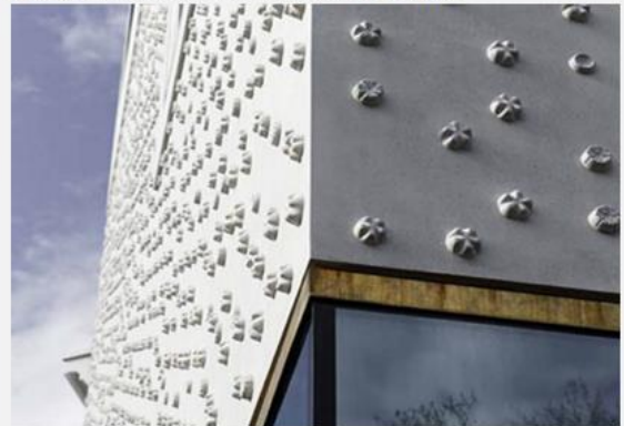
Virágok betonból. A PET palackok levágott fenéke sablonként szolgált
