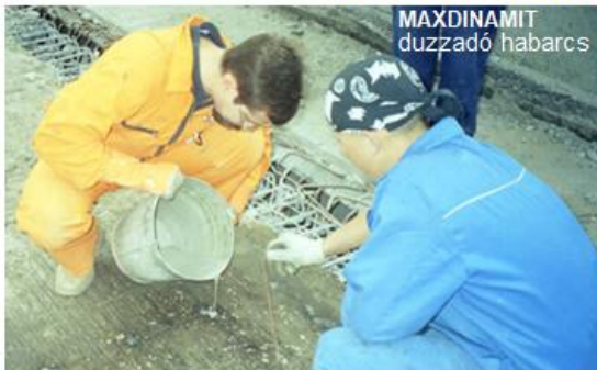
A fűrt lyukak kiöntése duzzadó habarccsal
