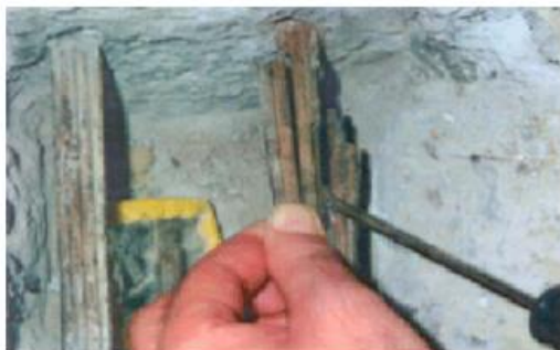
Feszültség (alatti) korrózió
