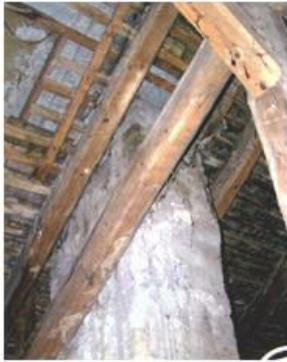
Fa tetőszerkezet égése
