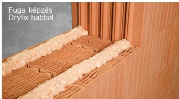
Cella üregek kitöltése (hőszigetelés)
