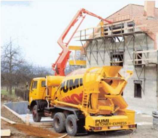
Mixer gépkocsi betonszivattyúval
