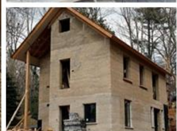
Betömörített falszerkezet
