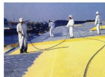
Helyszínen szórt hőszigetelés
