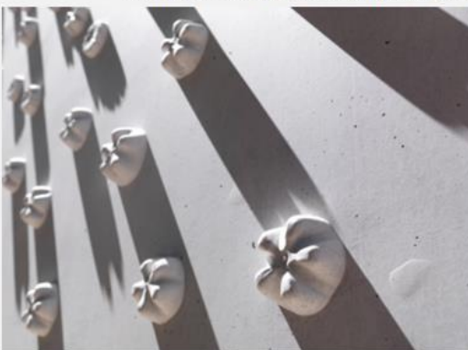
Virágok betonból. A PET palackok levágott fenéke sablonként szolgált
