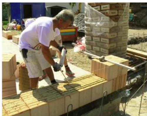
POROTHERM DRYFIX technológia
