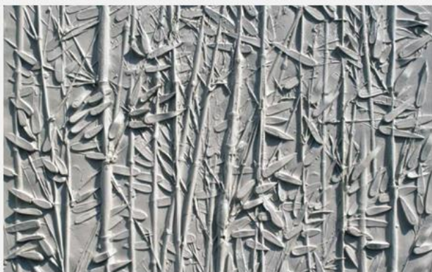
Matricás zsaluzattal készült látványbeton felületek
