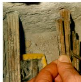
A „Magas ház” korróziós károsodása
