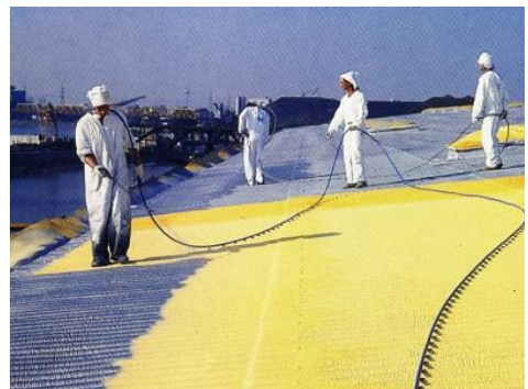
Helyszínen szórt hőszigetelés
