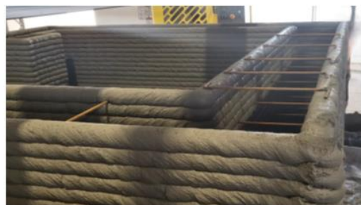
Falszerkezet összekapcsolása betonacélokkal
