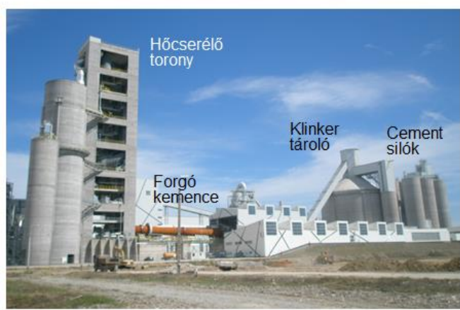
Cementgyártás berendezései és a gyár távlati képe
