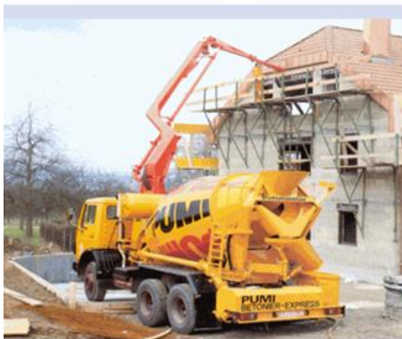
Mixer gépkocsi betonszivattyúval
