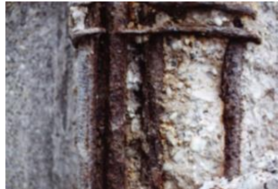
Vasbeton korrózió
