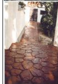
Lenyomatos mintázatú útburkolat készítése
