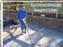
útburkolat alap készítés
