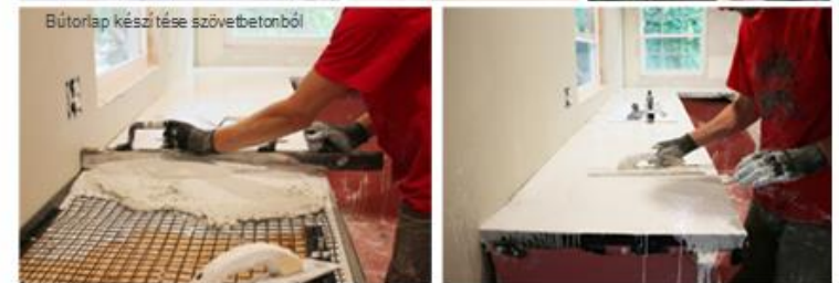
Bútortalpok készítése szövetbetonból
