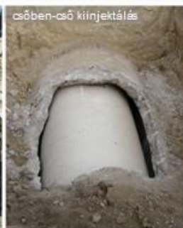
épületszerkezeti üregfeltöltés
