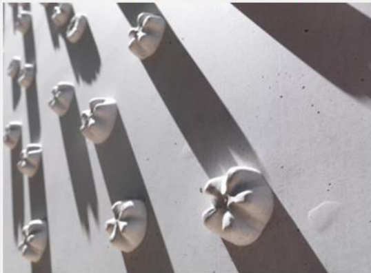
Virágok betonból. A PET palackok levágott feneke sablonként szolgált
