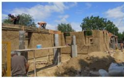
Vályogépület kivitelezése vert falas technológiával
