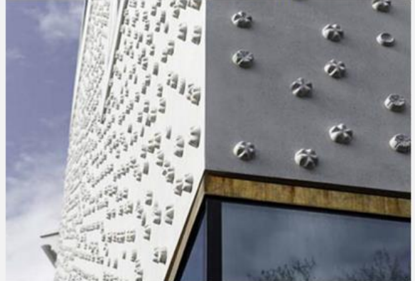
Virágok betonból. A PET palackok levágott feneke sablonként szolgált
