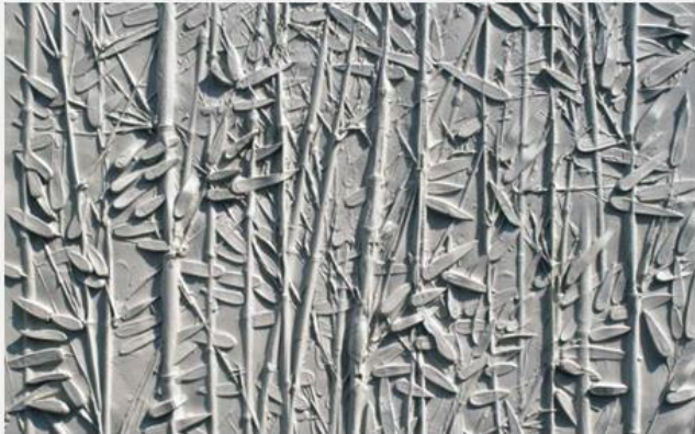
Matricás zsaluzattal készült látványbeton felületek
