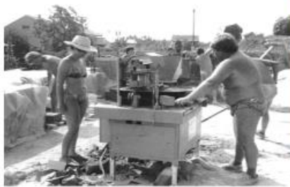
Vályog-föld falazóanyagok előállítás extruderrel és prégéppel (Pécs)
