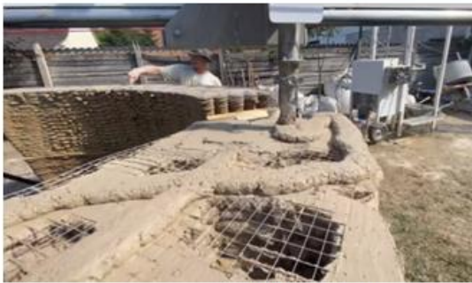
Vályogház (szauna) 3D nyomtatása. Kecskemét 2023.
