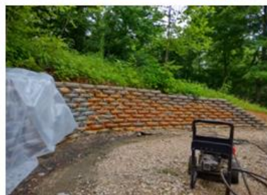
Papírszakok leáztatása a betonfalról
