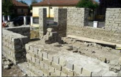
Préselt vályogtéglák és beépítésük a falazatba
