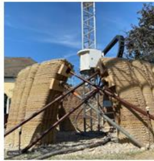
Vályogház (szauna) 3D nyomtatása. Kecskemét 2023.
