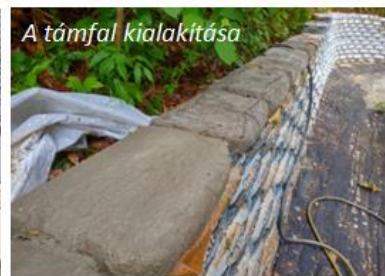
A falazat mögötti szivargó kialakítása
