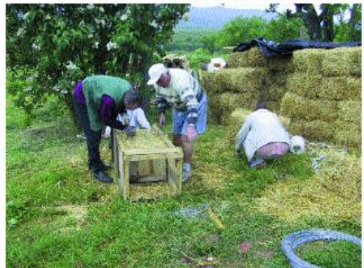
Szalmabálák készítése ládakalodában
