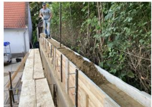
A vert vályogfal bedöngölése
