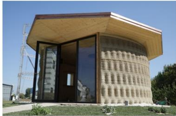
Agyag épület „Delta” rendszerű 3D nyomtatása, Olaszország (2018)
