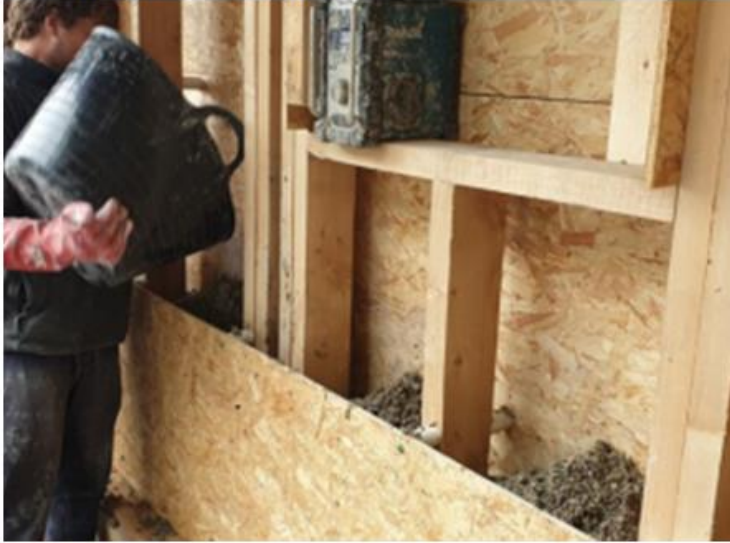
Kenderbeton bedolgozása falszerkezetbe
