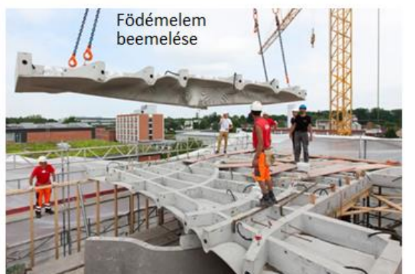
Födémlemez zsaluzatának előállítása 3D kötőanyag sugaras nyomtatóval
