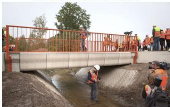
A híd üzembe helyezése ( H = 8\text{m} Sz = 3,5\text{m} )
