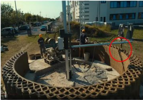
Agyag épület „Delta” rendszerű 3D nyomtatása, Olaszország (2018)
