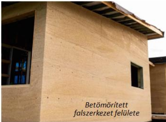
Tömörítéses technológiával épített kenderházak
