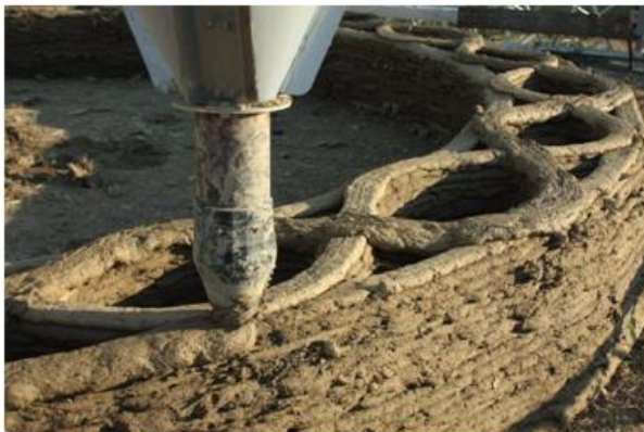
Delta rendszerű 3D nyomtatás, szalma adalékos helyi vályogból (Ravenna)
