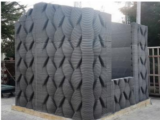
Agyag épület „Delta” rendszerű 3D nyomtatása, Olaszország (2018)
