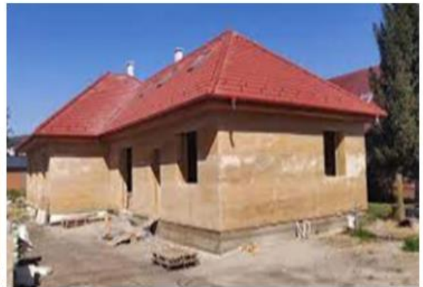
Tömörítéses technológiával épített kenderházak
