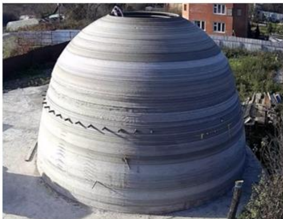
„Printed House” Kupolás épület 3D-s nyomtatása (Ø 9m, 7 nap)
