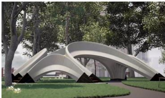
Habarc és betonacél erősítés nélküli hídszerkezet
