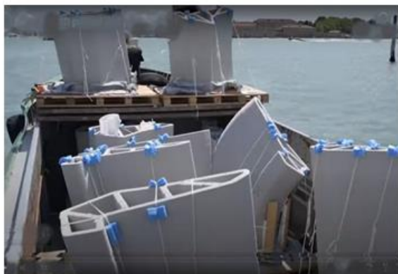
A híd elemeinek helyszínre szállítása
