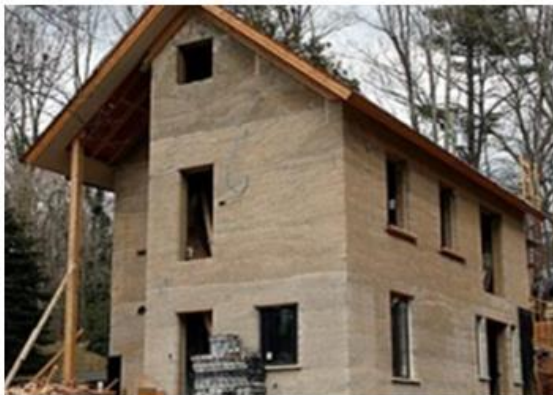
Tömörítéses technológiával épített kenderházak
