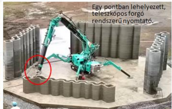
Teleszkópos mobildaru rendszerű nyomtató
