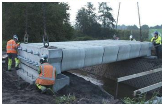
A híd elemeinek összeszerelése és feszítése
