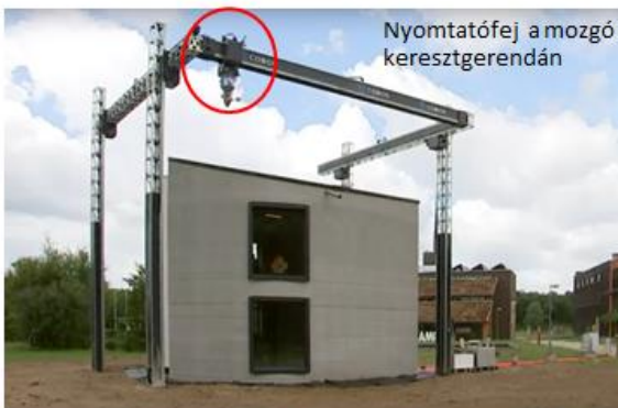
3D betonnyomtatás extruderes technológiával (nyomtatófej)
