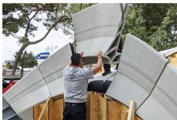
A híd betonelemeinek beemelése
