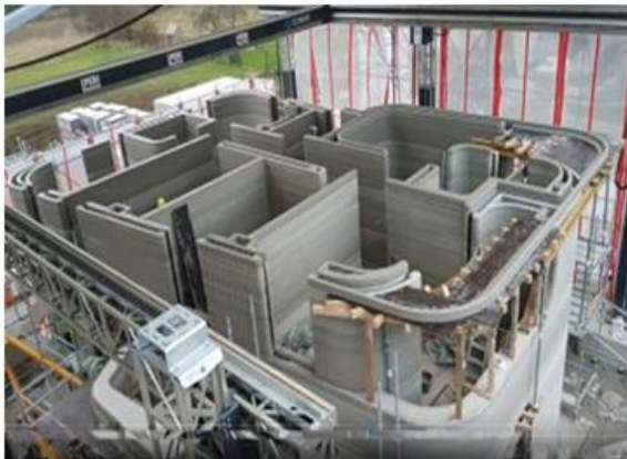
Betonépület extruder 3D nyomtatása és építése (Németország)
