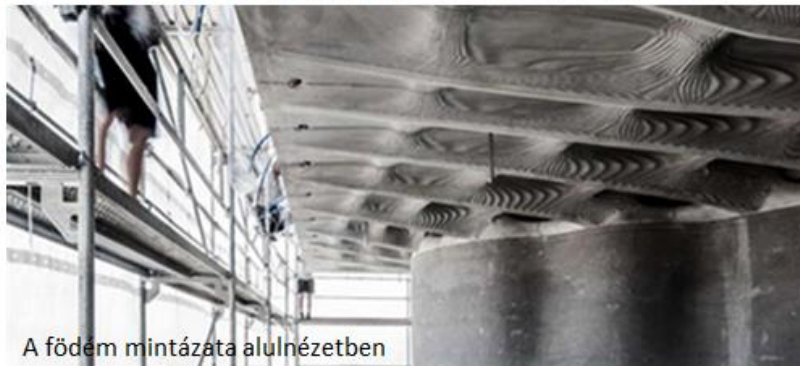
Födémlemez előállítása 3D nyomtatással készült zsaluzattal (Zurick)
