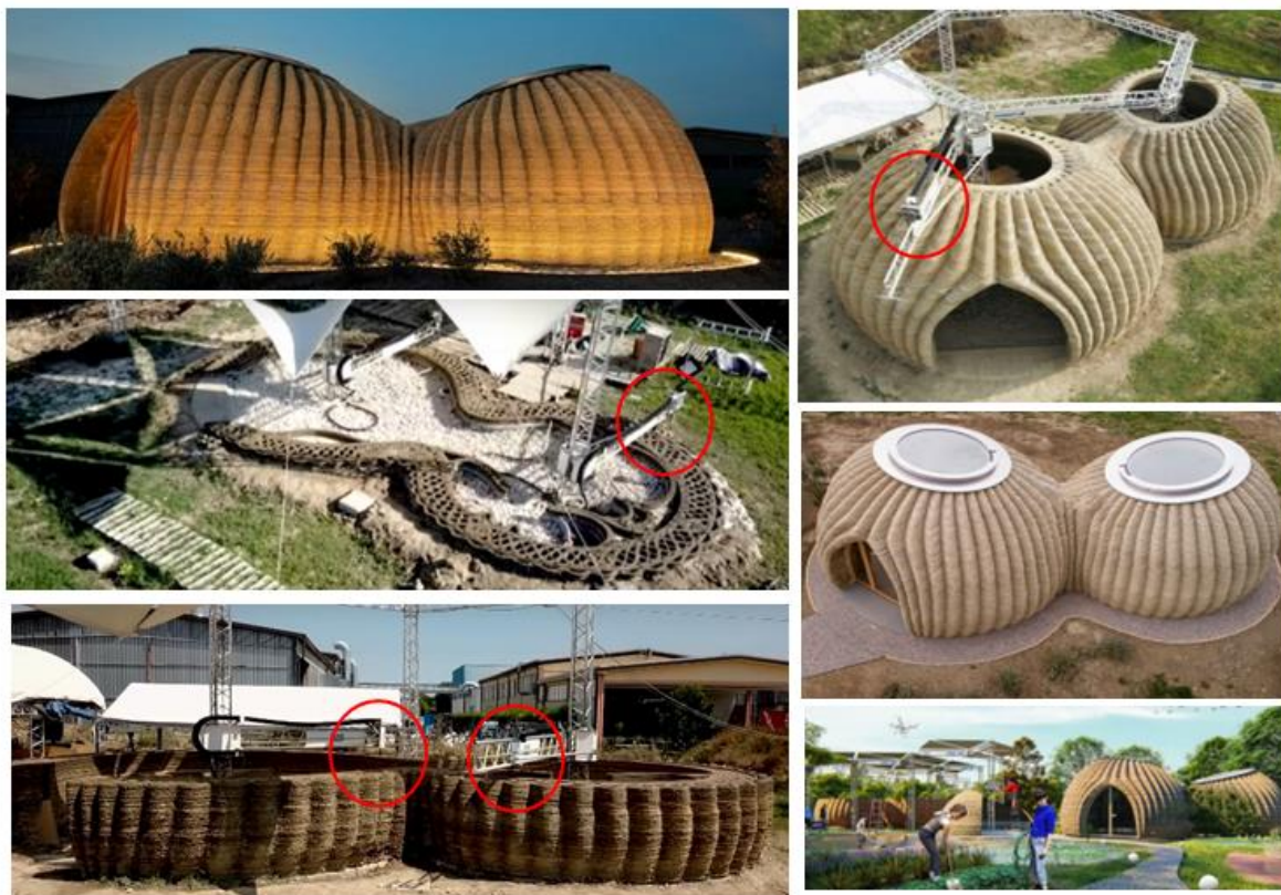
Vályog épület „Delta” rendszerű 3D nyomtatása, Olaszország
