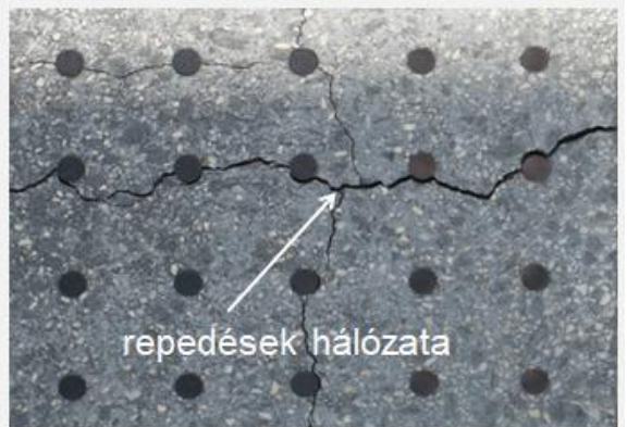
A pixelbeton falpanelek repedései
