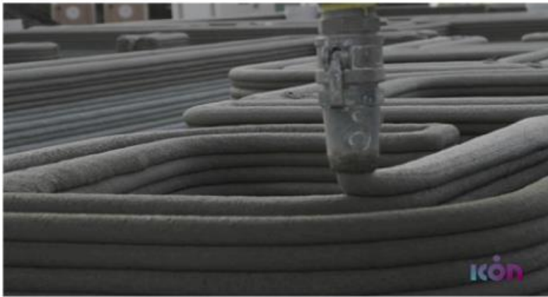
A nyomtatófejet elhagyó friss betonrétegek
