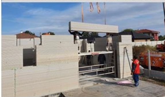
Épület szerelése előre nyomtatott panelelemből (Szlovákia)
