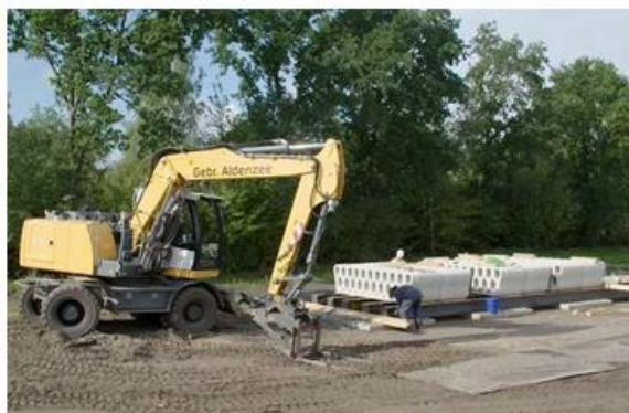
A helyszínre szállított hídlembek
