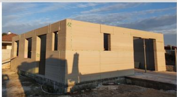
Épület szerelése előre nyomtatott panelelemből (Szlovákia)
