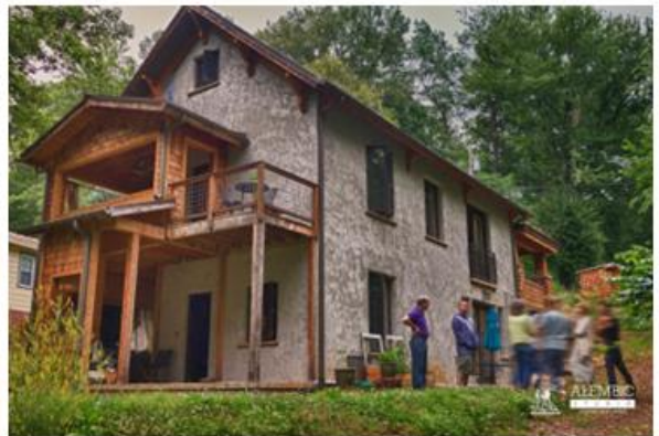
Tömörítéses technológiával épített kenderházak
