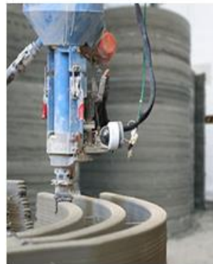
3D betonnyomtatás extruderes technológiával (nyomtatófej)
