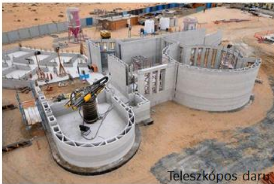
Betonépület extruderes 3D nyomtatása és építése (Németország)
