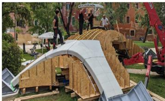
Hagyományos boltíves hídkonstrukció kialakítása
