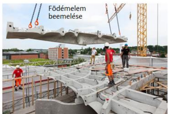
Födémlemez zsaluzatának előállítása 3D kötőanyag sugaras nyomtatóval
