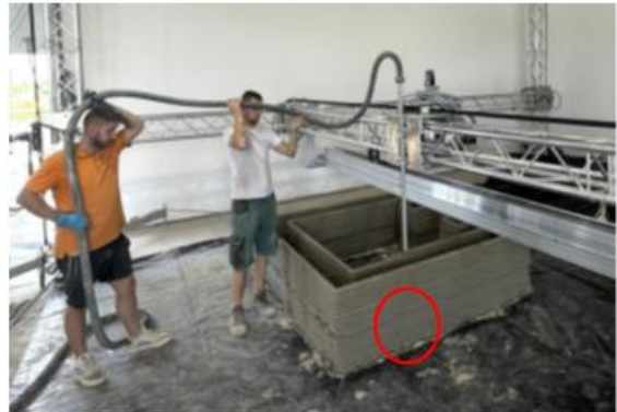
A nyomtatott építmény falzatának kialakítása
