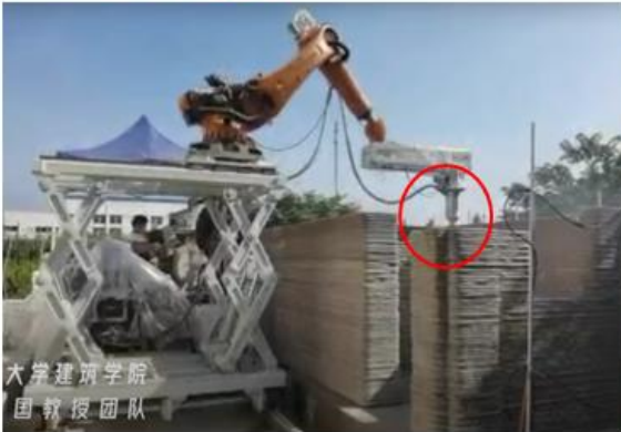
Robotkaros és portál technológiát egyesítő nyomtatók
