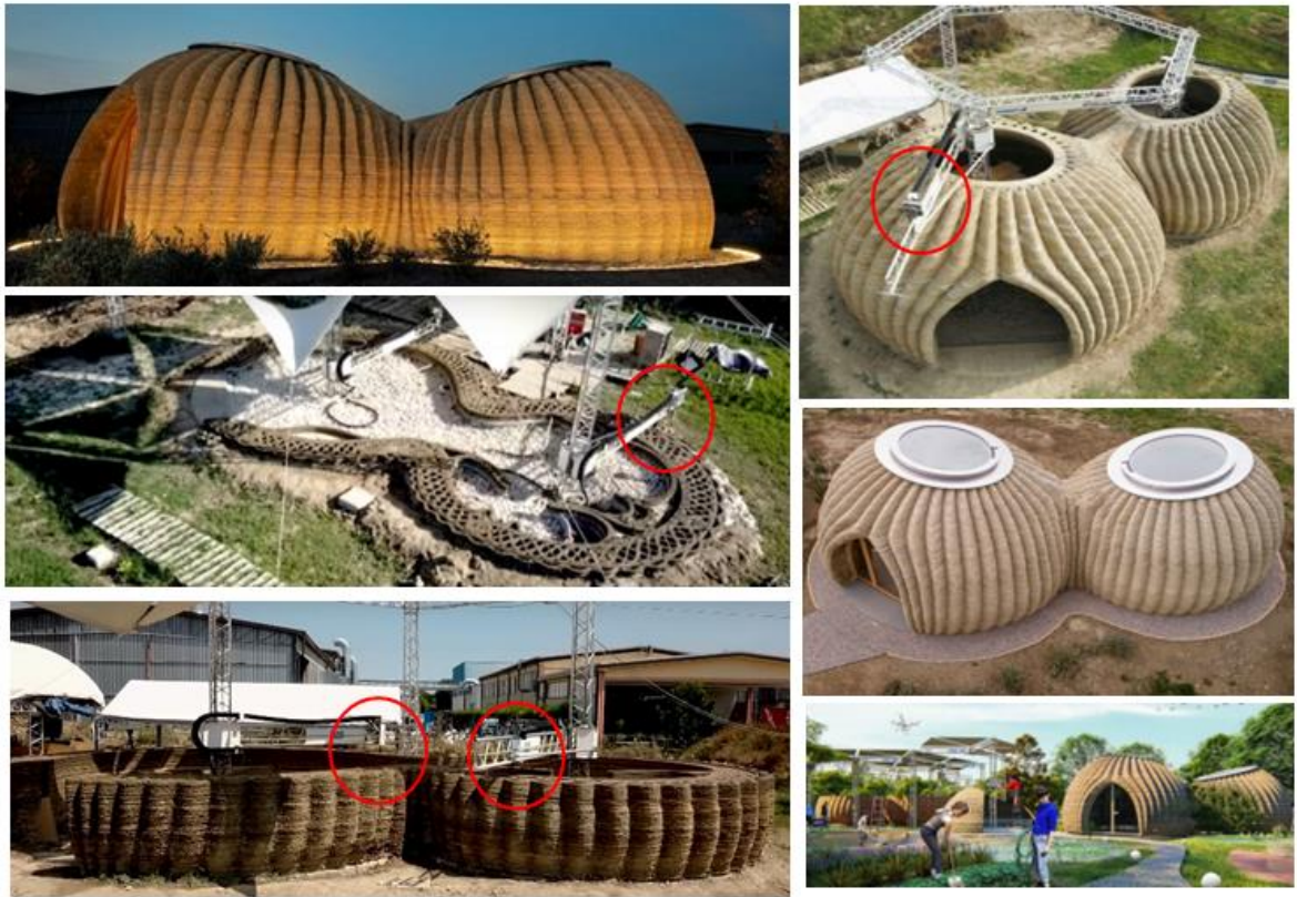
Vályog épület „Delta” rendszerű 3D nyomtatása, Olaszország
