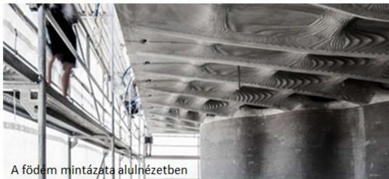
Födémlemez előállítása 3D nyomtatással készült zsaluzattal (Zurick)
