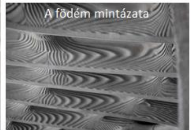
Födémlemez előállítása 3D nyomtatással készült zsaluzattal (Zurick)
