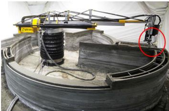
Teleszkópos darurendszerű nyomtatók
