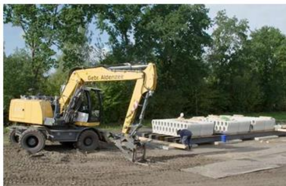
A helyszínre szállított hídelemek
