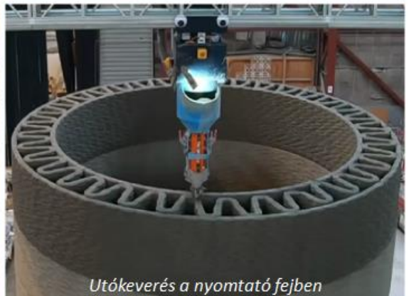
Fixkeretes portálrendszerű nyomtatók
