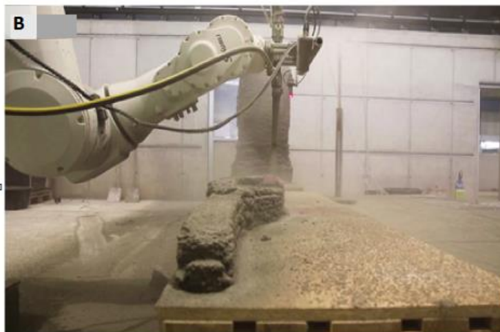
Falszerkezet formázása lőtt betonnal
