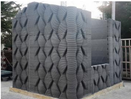
Agyag épület „Delta” rendszerű 3D nyomtatása, Olaszország (2018)
