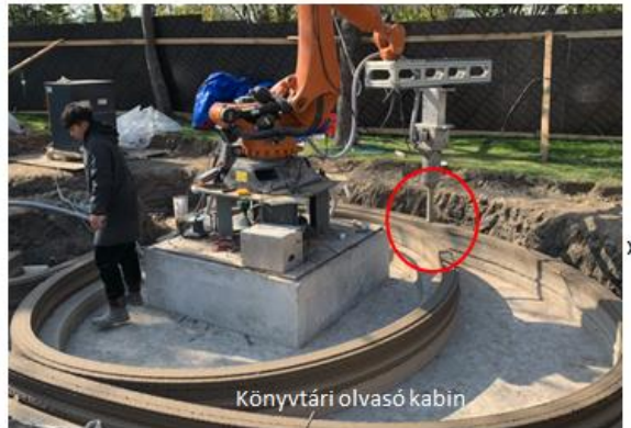
Robotkaros és portál technológiát egyesítő nyomtatók
