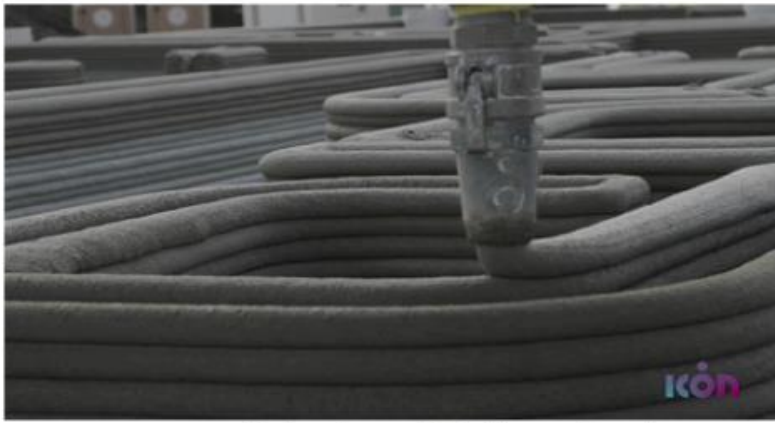
A nyomtatófejet elhagyó friss betonrétegek
