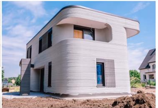
Betonépület extruderes 3D nyomtatása és építése (Németország)
