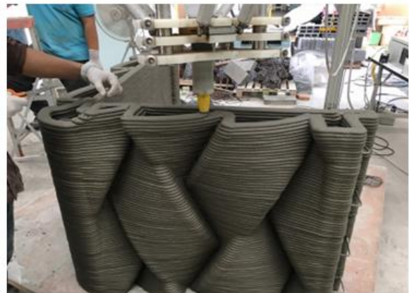
Agyag épület „Delta” rendszerű 3D nyomtatása, Olaszország (2018)
