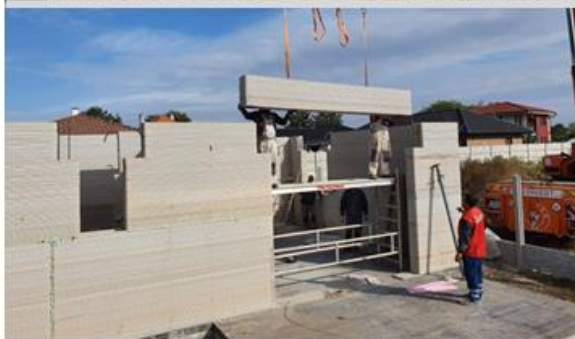
Épület szerelése előre nyomtatott panelelemből (Szlovákia)
