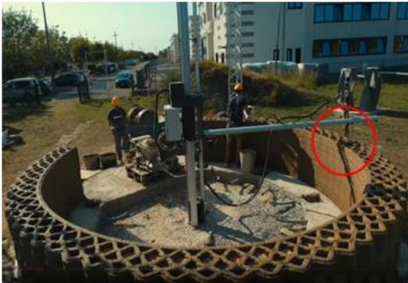
Agyag épület „Delta” rendszerű 3D nyomtatása, Olaszország (2018)
