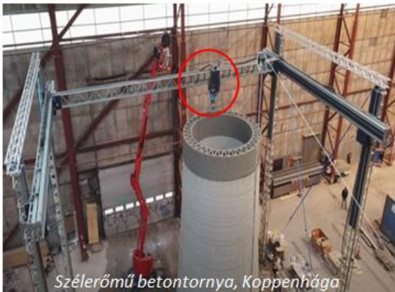
Fixkeretes portálrendszerű nyomtatók
