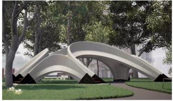
Habarc és betonacél erősítés nélküli hídszerkezet
