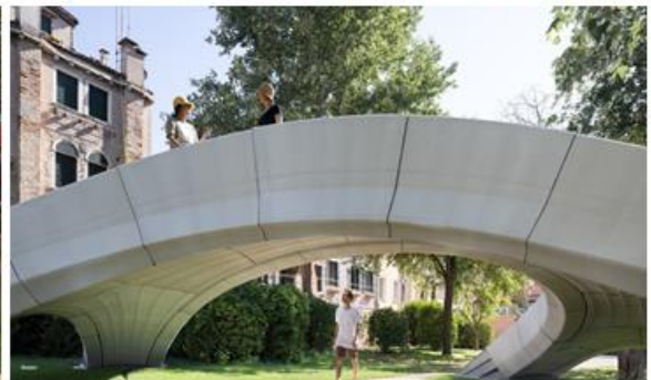
A betontömb elemek ívet alkotnak
