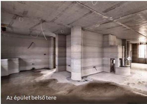
Betonépület extruderes 3D nyomtatása és építése (Németország)
