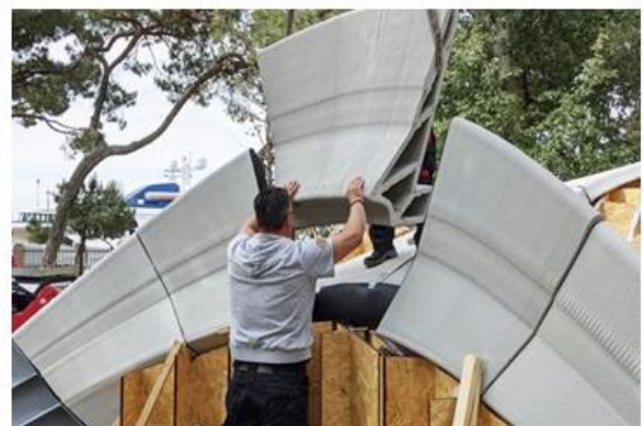
A híd betonelemeinek beemelése
