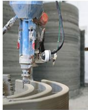
3D betonnyomtatás extruderes technológiával (nyomtatófej)
