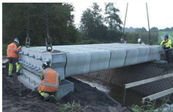
A híd elemeinek összeszerelése és feszítése
