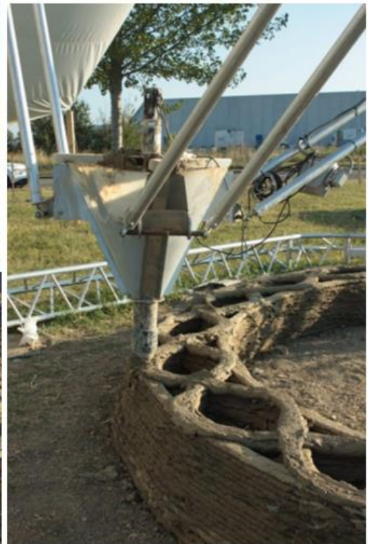
Delta rendszerű 3D nyomtatás, szalma adalékos helyi vályogból (Ravenna)
