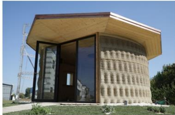
Agyag épület „Delta” rendszerű 3D nyomtatása, Olaszország (2018)
