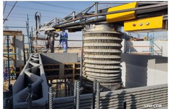
Betonépület extruderes 3D nyomtatása és építése (Németország)
