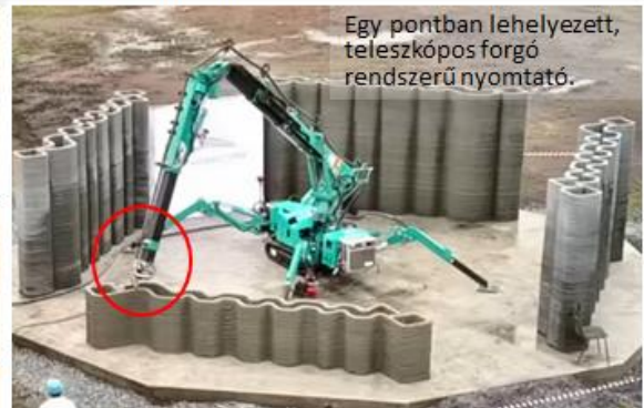
Teleszkópos mobildaru rendszerű nyomtató
