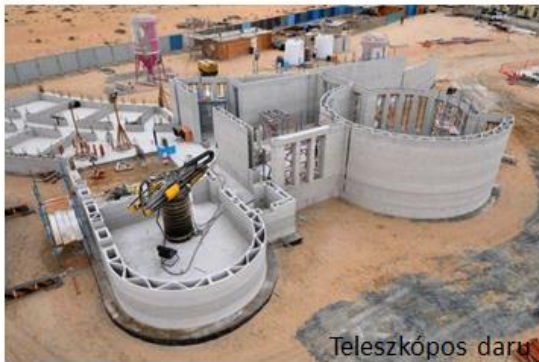
Betonépület extruderes 3D nyomtatása és építése (Németország)
