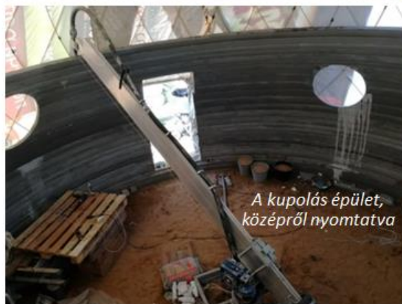
„Printed House” Kupolás épület 3D-s nyomtatása (Ø 9m, 7 nap)
