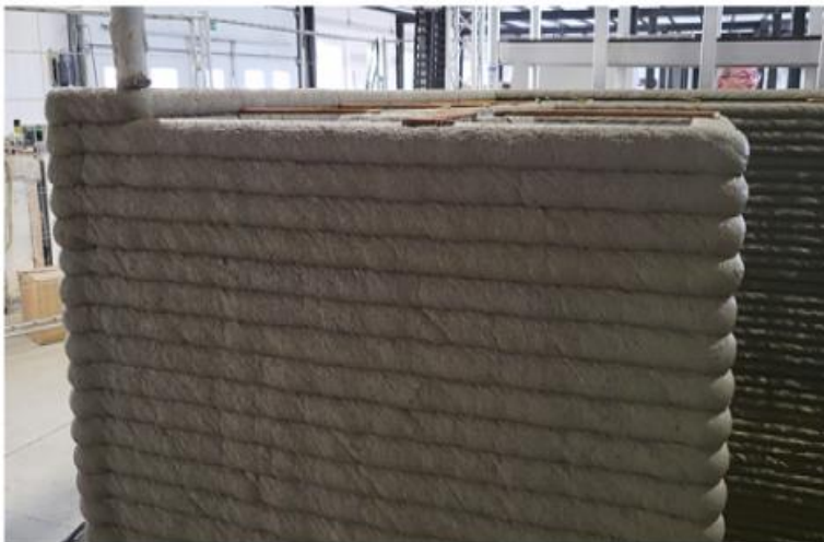
A falszerkezet nyomtatása (Turbotech, Szeged 2022)
