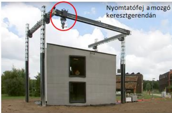
3D betonnyomtatás extruderes technológiával (nyomtatófej)
