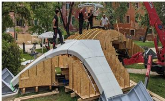
Hagyományos boltíves hídkonstrukció kialakítása
