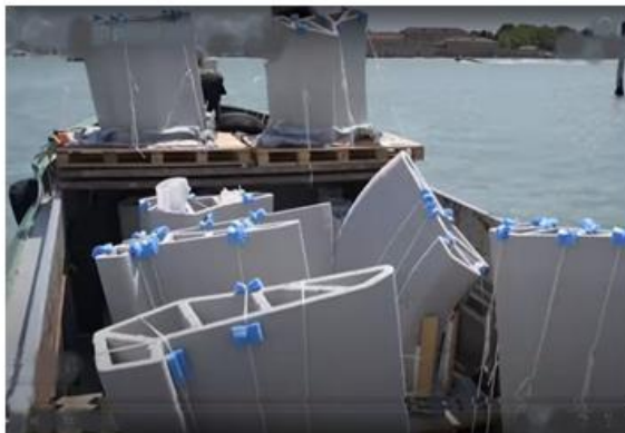
A híd elemeinek helyszínre szállítása
