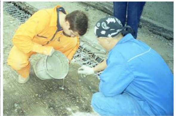
A fűrt lyukak kiöntése duzzadó habarccsal
