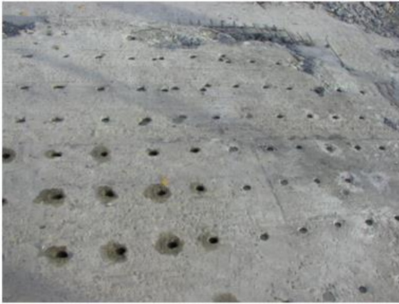
A fűrt lyukak kiöntése duzzadó habarccsal
