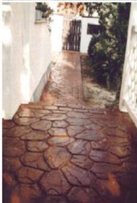
Lenyomatos mintázatú útburkolat készítése
