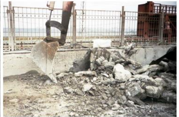
A pályalemez betontörmelékének elszállítása
