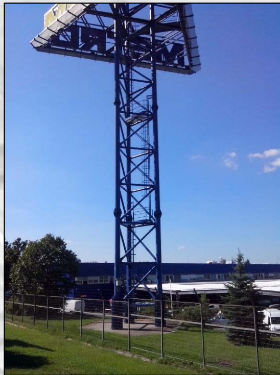
11-12-13. kép. Térbeli rácsos tartóval kialakított oszlop
