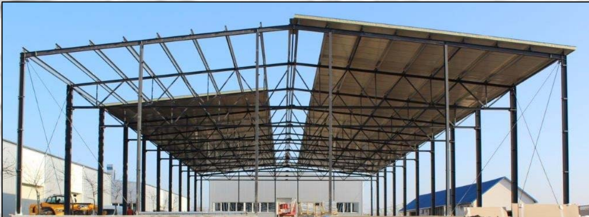
3. kép. Csarnoképület Z szelemennel [ www.eptar.hu ]
