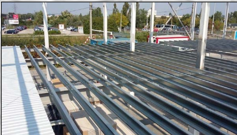
3. kép. Csarnoképület Z szelemennel [ www.eptar.hu ]
