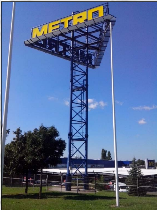
11-12-13. kép. Térbeli rácsos tartóval kialakított oszlop
