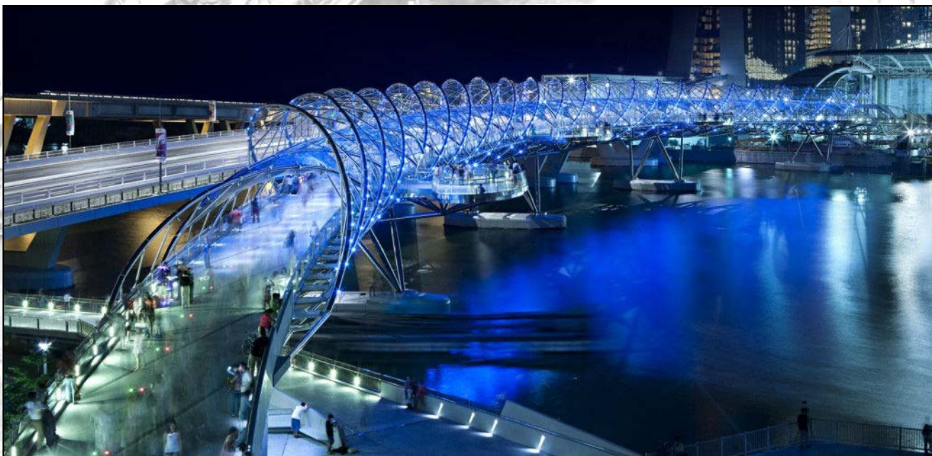
5-6. kép. Helix Bridge (Szingapúr) [ www.arch2o.com ]
