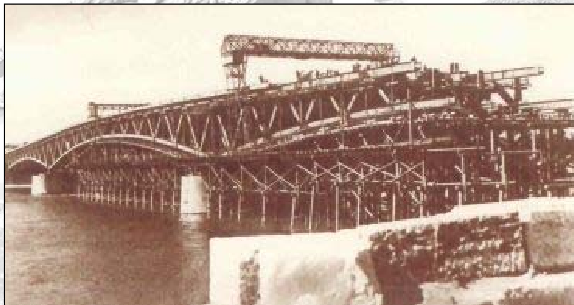
3-4. kép. Horthy Miklós (Petőfi) híd állványzata (1936) [Iványi M. 2008, www.sulinet.hu ]
