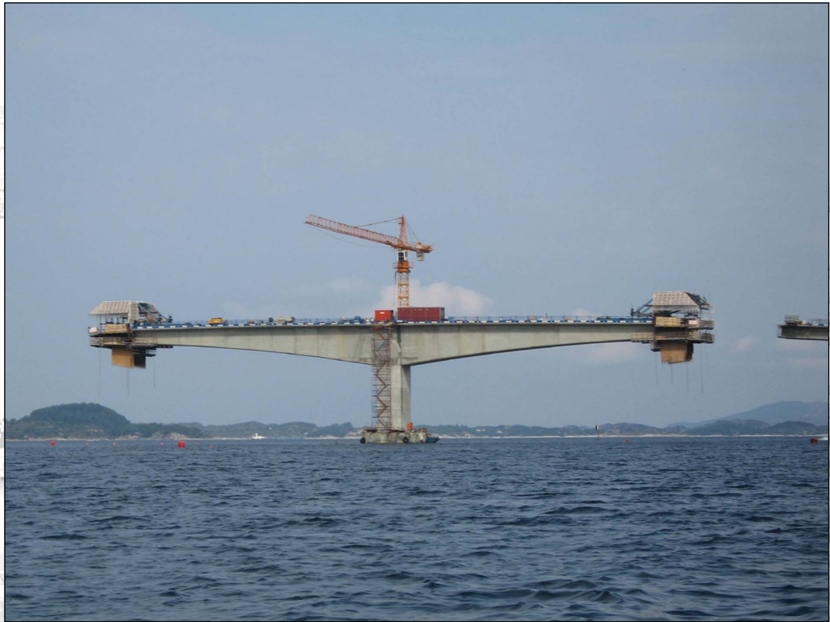
19. kép. Hídépítés szabad betonozással [Orbán Z. 2017]
