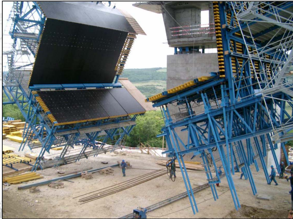
28-29. kép. Betonozó kocs szerkezete és mozgatása, Kőröshegyi völgyhíd [Orbán Z. 2017]
