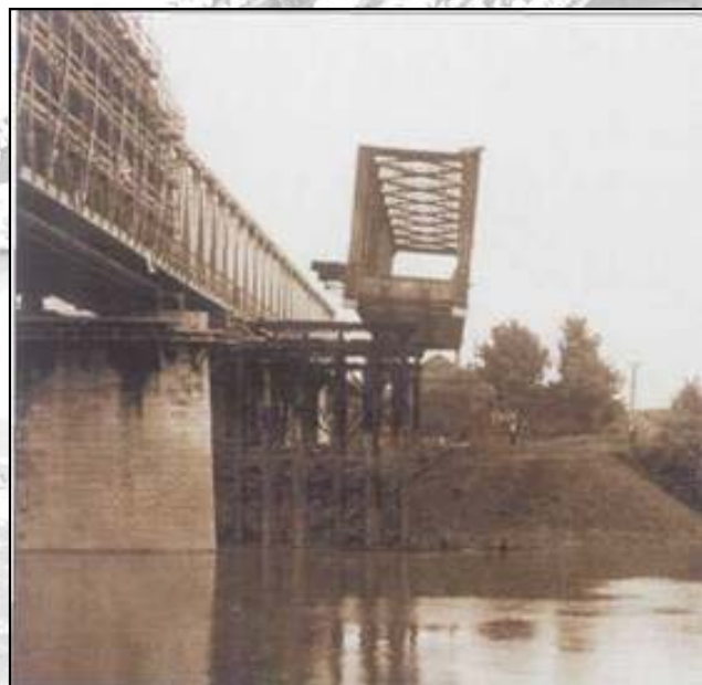
5-6. kép. Algyő Tisza-híd szerelése (1960) [Iványi M. 2008]
