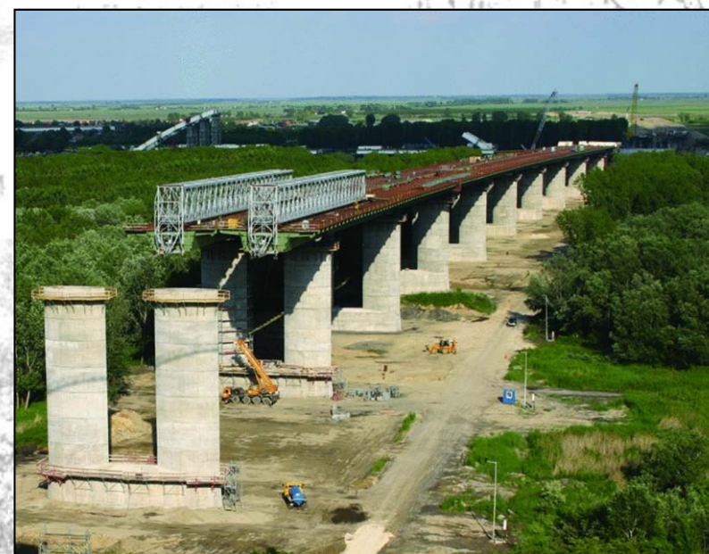
15-18. kép. Pentele híd építése vendéghíddal [MAGÉSZ 2005, www.nagydaniel.wordpress.com , www.matud.iif.hu ]
