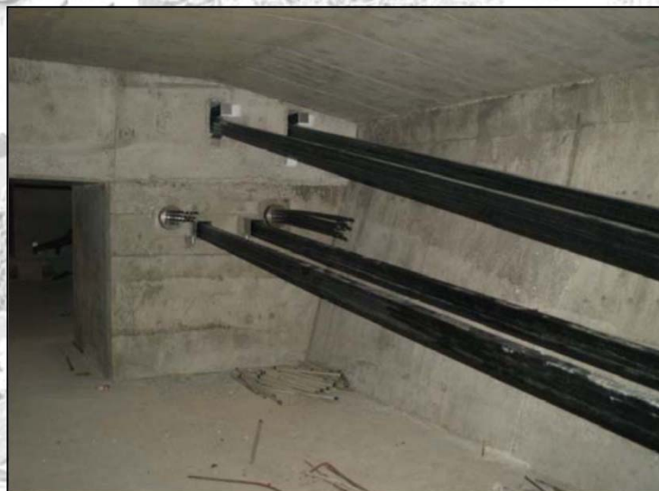
21. ábra. Feszítőpászma kialakítása IV. [Orbán Z. 2017]
