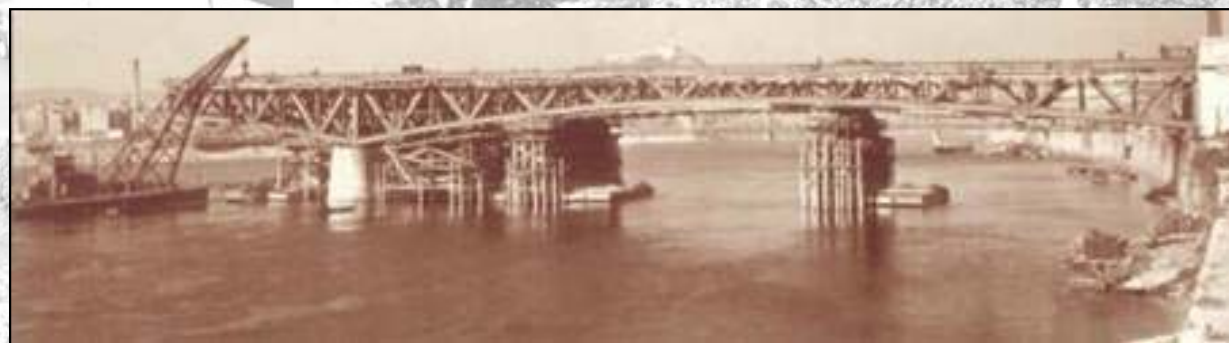
11-13. kép. Petőfi (Horthy Miklós) híd újjáépítése, szabadszerelés egyirányban (1951) [www.sulinet.hu]
