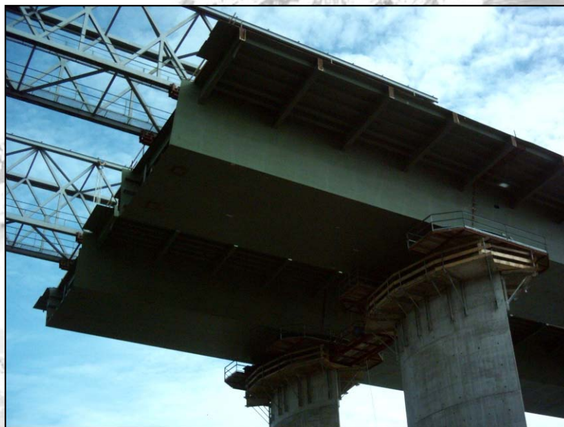
15-18. kép. Pentele híd építése vendéghíddal [MAGÉSZ 2005, www.nagydaniel.wordpress.com , www.matud.iif.hu ]
