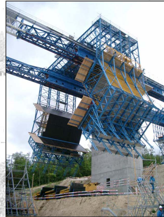
28-29. kép. Betonozó kocs szerkezete és mozgatása, Kőröshegyi völgyhíd [Orbán Z. 2017]
