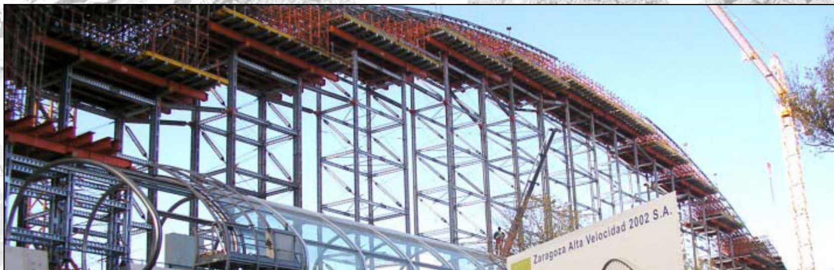
1-2. kép. Ívhidak építése hagyományos és korszerű állványzattal [Orbán Z. 2017]
