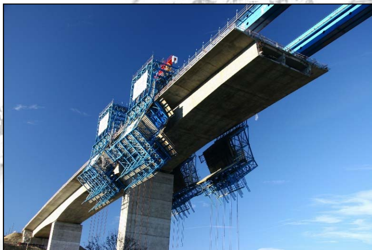
20-23. kép. Szabad betonozás, Köröshegyi völgyhíd építése
