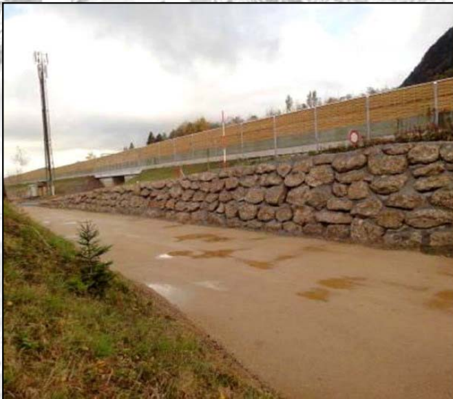
17. ábra. Beton súlytámfal [www.sze.hu]
