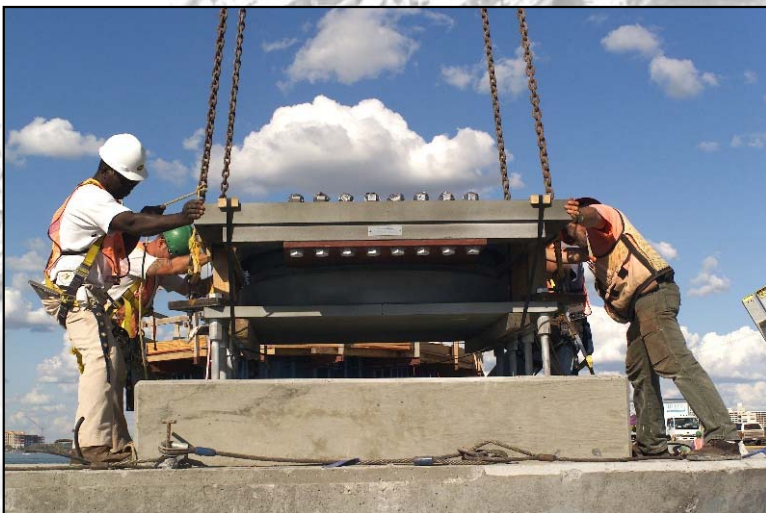
21-24. kép. Saruk elhelyezése [ www.archiexpo.com , www.mageba.ch , www.techstar-inc.com ]
