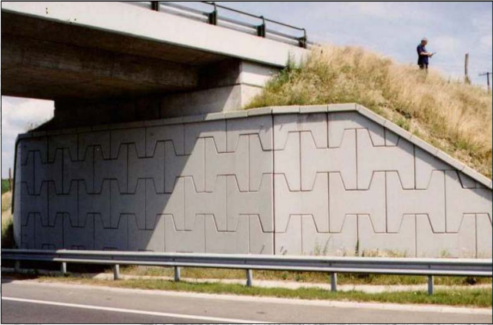
7. kép. H-típusú vasalttalaj támfal kialakítása [Szepesházi R. 2012]
