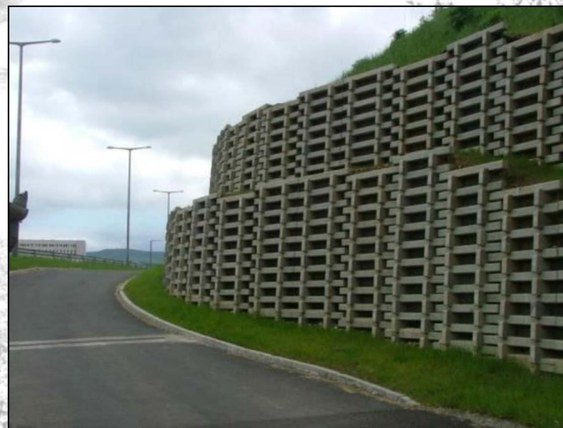
15-18. kép. Máglyafal kialakítása előregyártott vasbeton elemekkel [www.sze.hu]
