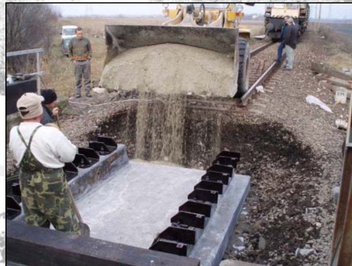
1-2. kép. Bordás kiegyenlítő lemez kialakítása vasúti hídnál [Orbán Z. 2017]
