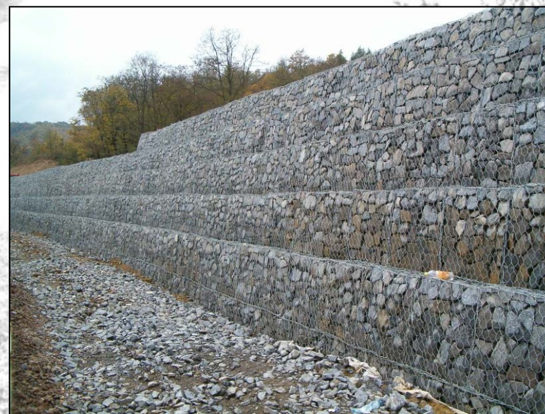
15-18. kép. Gabion támfal kialakítása [ www.koboxtamfal.hu , www.staticplan.hu , www.pelsoplan.hu , www.viaconhungary.hu ]
