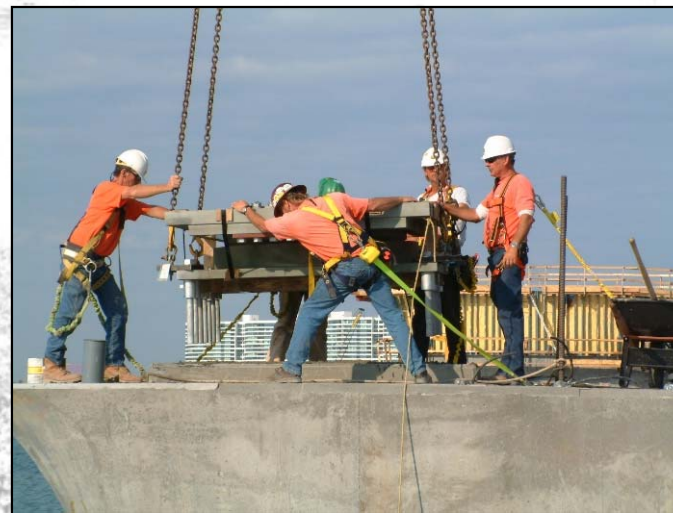
21-24. kép. Saruk elhelyezése [ www.archiexpo.com , www.mageba.ch , www.techstar-inc.com ]
