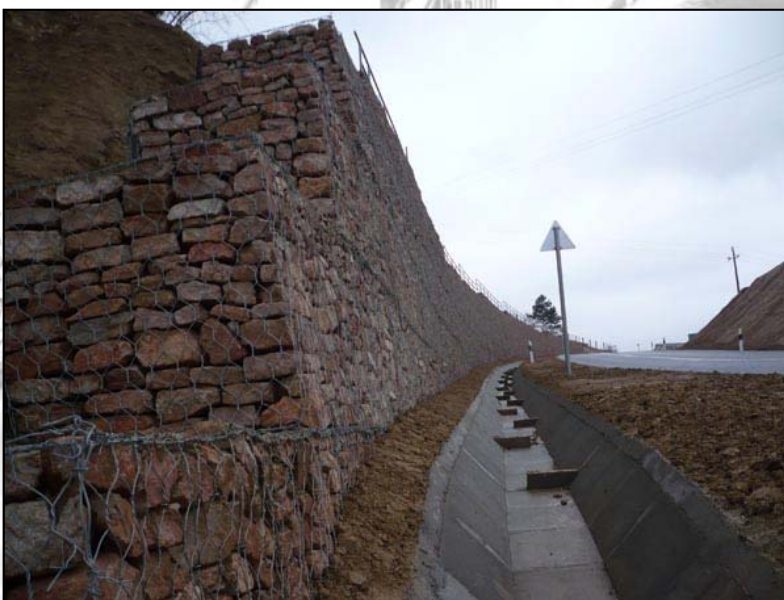
15-18. kép. Gabion támfal kialakítása [ www.koboxtamfal.hu , www.staticplan.hu , www.pelsoplan.hu , www.viaconhungary.hu ]
