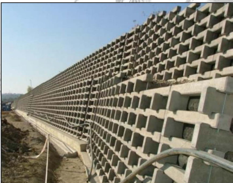
15-18. kép. Máglyafal kialakítása előregyártott vasbeton elemekkel [www.sze.hu]
