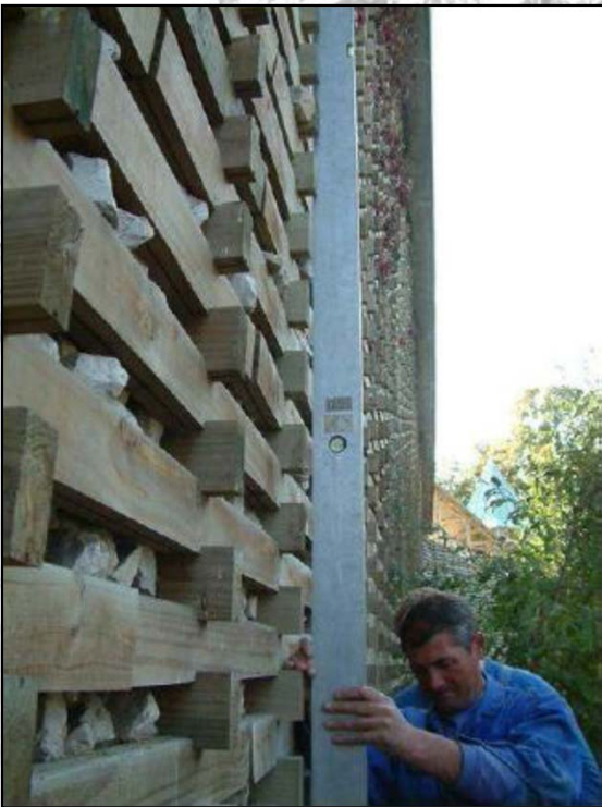
19-22. kép. Hűvösvölgy, máglyafal kialakítása fából [www.sze.hu]
