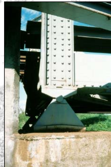
19. kép. Acélöntvény billenősaru [www.forum.index.hu]
