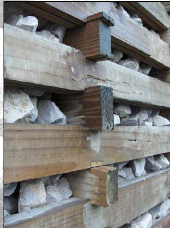
19-22. kép. Hűvösvölgy, máglyafal kialakítása fából [www.sze.hu]
