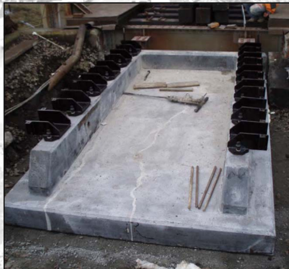
1-2. kép. Bordás kiegyenlítő lemez kialakítása vasúti hídnál [Orbán Z. 2017]
