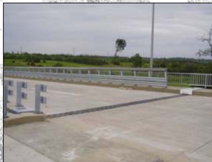
16. kép. Az elkészült dilatációs szerkezet [Orbán Z. 2017]
