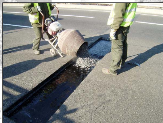
10-12. kép. Thorma Joint típusú rugalmas burkolatdilatáció [www.bitu-joint.oldalunk.hu]
