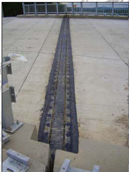
15. kép. A kiöntött pályaburkolat csatlakoztatása [Orbán Z. 2017]
