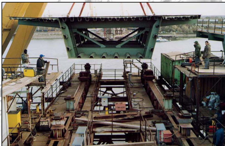
4-6. kép. Pentele híd ártéri hídelemeinek gyártása [MAGÉSZ 2013]
