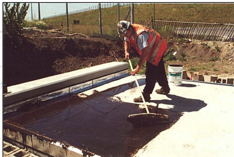
27. kép. Szigetelőanyag felhordása [Orbán Z. 2017]
