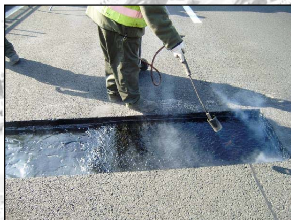
10-12. kép. Thorma Joint típusú rugalmas burkolatdilatáció [www.bitu-joint.oldalunk.hu]
