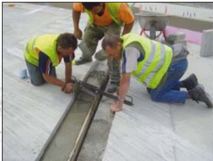
13. kép. Habarcskiegyenlítő réteg készítése [Orbán Z. 2017]
