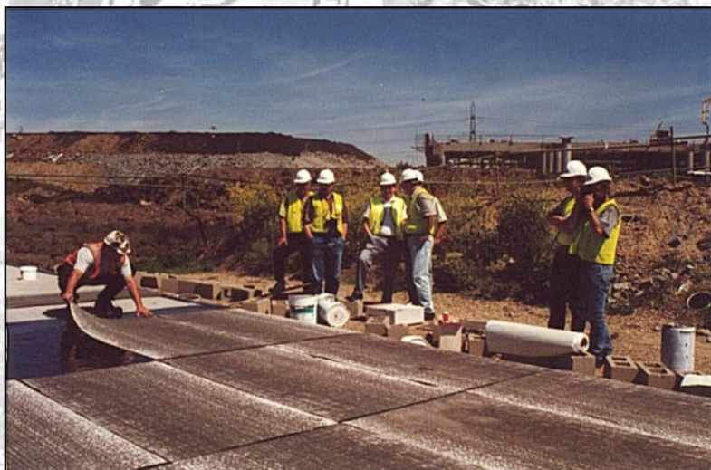
28. kép. Servipak védőtáblák fektetése [Orbán Z. 2017]
