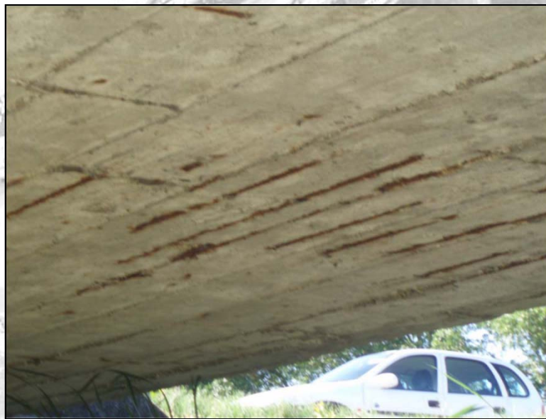
1-2. kép. Vasbetonszerkezetű hidak károsodása I. [Orbán Z. 2017]
