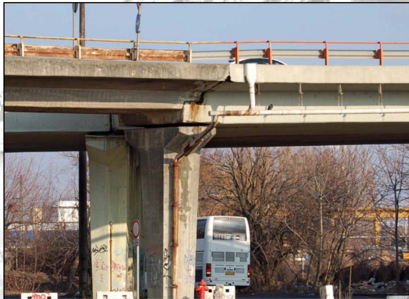
3-6. kép. Vasbetonszerkezetű hidak károsodása II. [Orbán Z. 2017]
