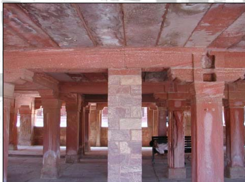
14. kép. Előregyártott kőfödém a IX. századból [Kiss R. 2007]
