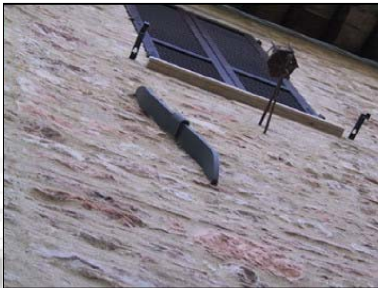
9. kép. Középkor – faltartó vasak 2. [Kiss R. 2007]
