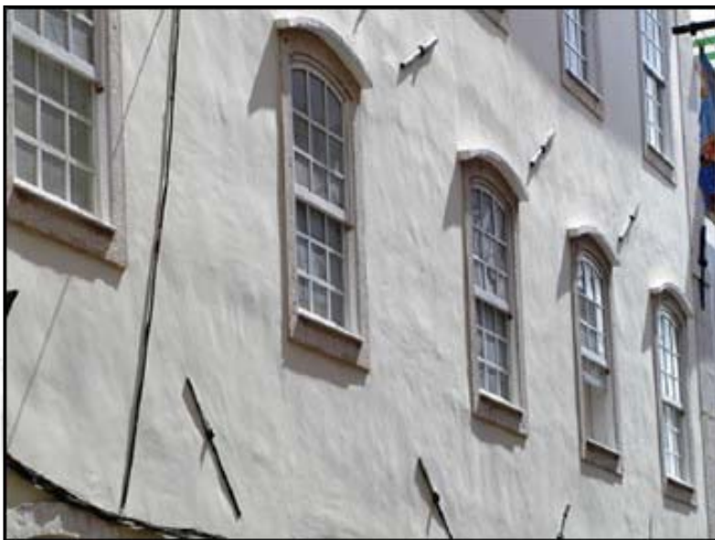
8. kép. Középkor – faltartó vasak 1. [Kiss R. 2007]
