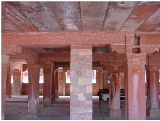
Előregyártott kőfödém a IX századból
