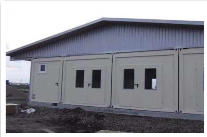
Konténer épületcsoport védőtető Szatmárnémeti
