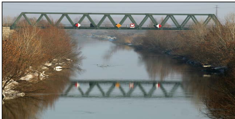
8. kép-11. ábra. Szimmetrikus rácsozás [Szabó I. G. 2012]
