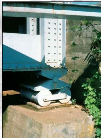
1. kép. Gördülő alátámasztás kialakítása [Szabó I. G. 2012]
