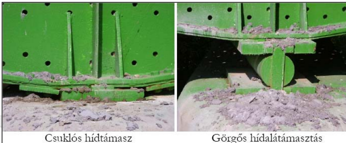
2. kép. Gördülő és csúszó alátámasztás kialakítása [Szabó I. G. 2012]
