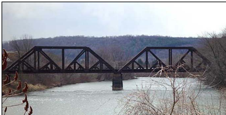
11. kép-14. ábra. Szimmetrikus rácsozás másodlagos elemekkel [Szabó I. G. 2012]
