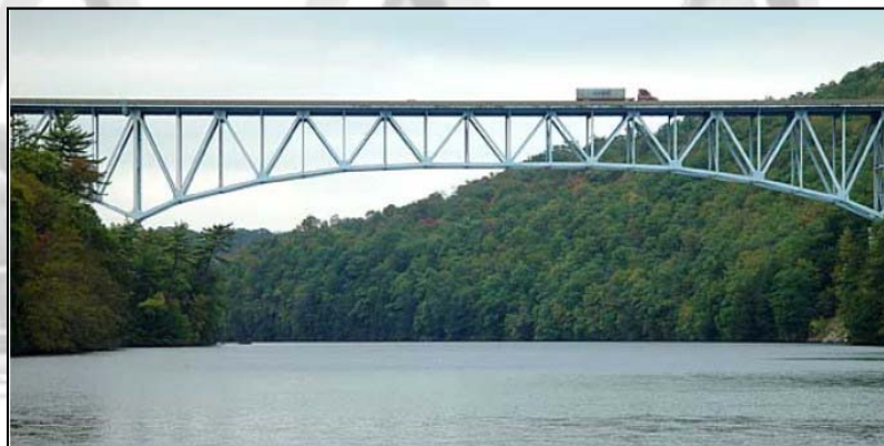
9. kép-12. ábra. Szimmetrikus rácsozás oszlopokkal [Szabó I. G. 2012]
