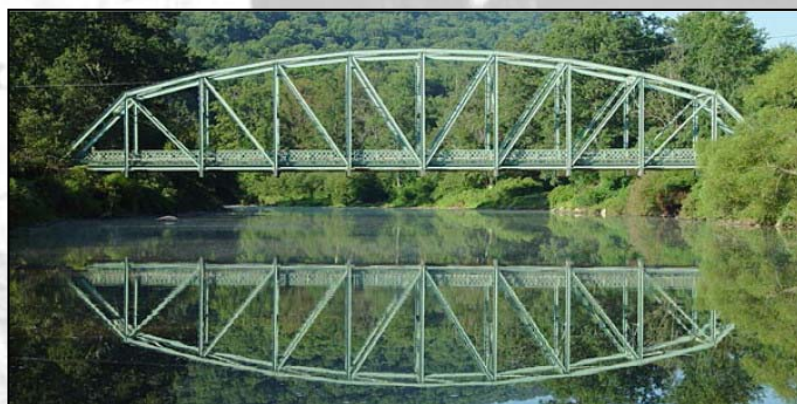
10. kép-13. ábra. Oszlopos rácsozás [Szabó I. G. 2012]
