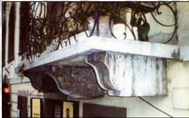
4. kép. Befogott (konzolos) megtámasztás kialakítása [Szabó I. G. 2012]
