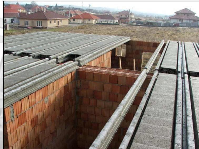
2. kép. Kéttámaszú előregyártott földégerendák [Szabó I. G. 2012]
