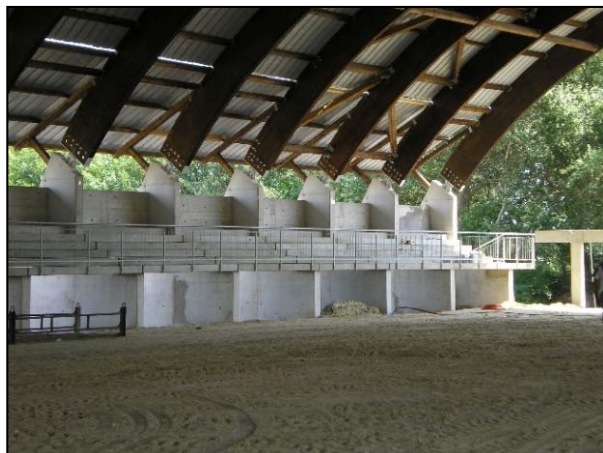
5-6-7. kép. Háromcsuklós tartó csuklóinak kialakítása
