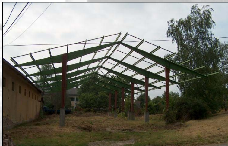
2. kép, 2. ábra. Háromcsuklós tartó II. és statikai váza [Szabó I. G. 2012]
