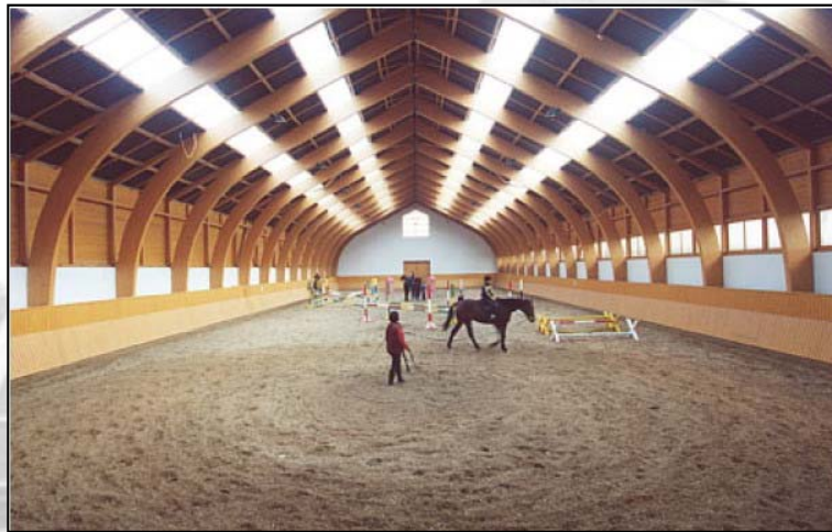
1. kép, 1. ábra. Háromcsuklós tartó I. és statikai váza [Szabó I. G. 2012]
