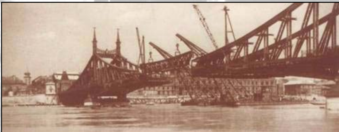
11. kép. A Szabadság híd szerelés közben [Szabó I. G. 2012]
