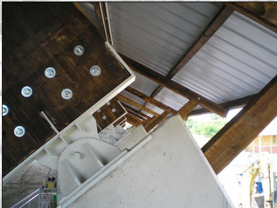
8-9. kép. Háromcsuklós tartó csuklóinak kialakítása
