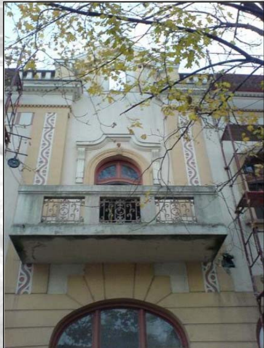
3. kép. Vasbeton erkélylemez [Szabó I. G. 2012]
