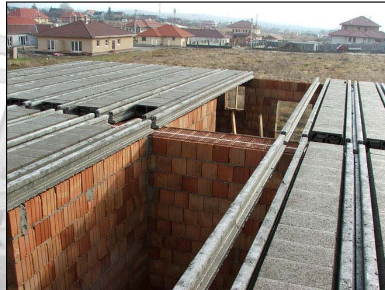
2. kép. Kéttámaszú előregyártott földemgerendák [Szabó I. G. 2012]
