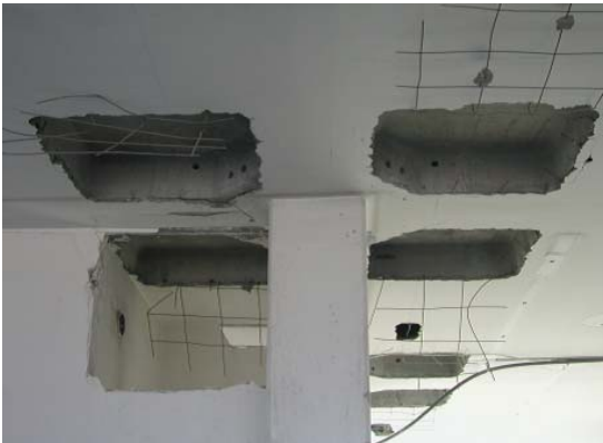
Feszítőpázmák a födémen belül vezetve
