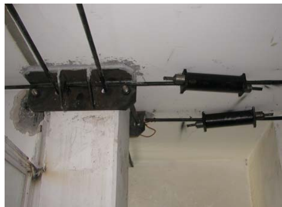
Feszítőpázmák a födémen belül vezetve
