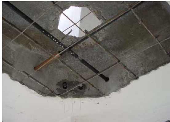
Feszítőpázmák a födémen belül vezetve
