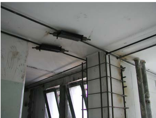
Feszítőpázmák a födémen belül vezetve
