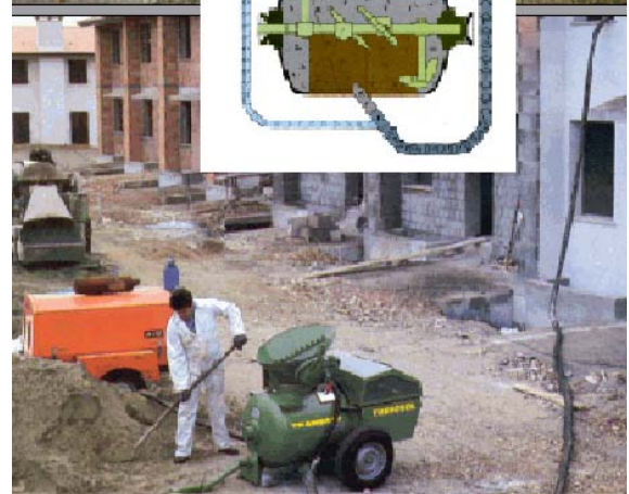
Betonszivattyú szerkezeti felépítése és alkalmazása
