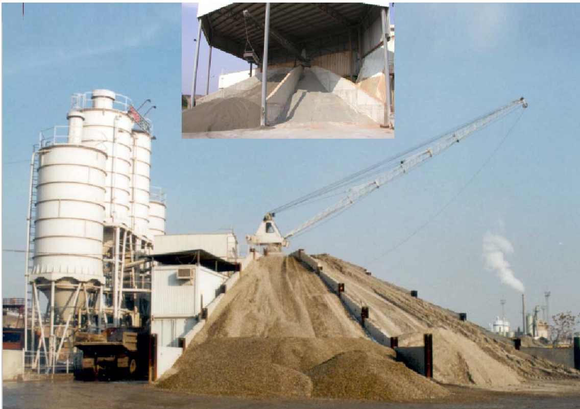
Horizontális elrendezésű betonkeverő telep
