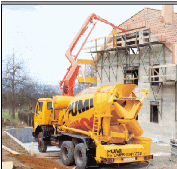
Betonszivattyú szerkezeti felépítése és alkalmazása
