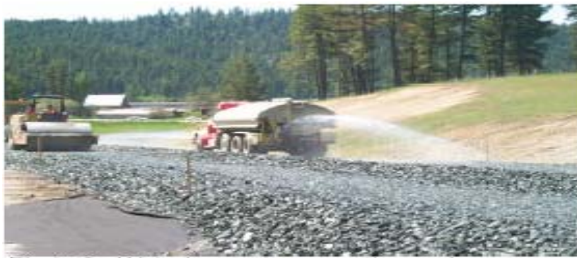
12.5. ábra. Alapréteg locsolása és tömörítése vibrohengerrel
