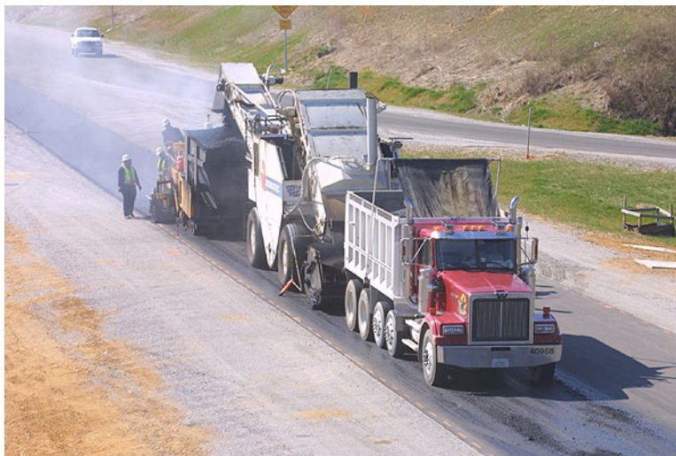
12.2. ábra. Aszfalt-bedolgozó géplánc
