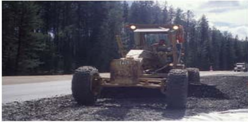
12.4. ábra. Adalékanyag elterítése gréderrel
