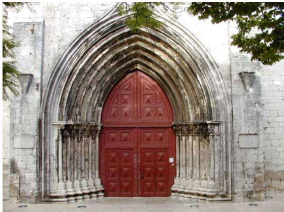
Középkor – faltartó vasak, íves megtámasztás, rózsablak, bejáratok
